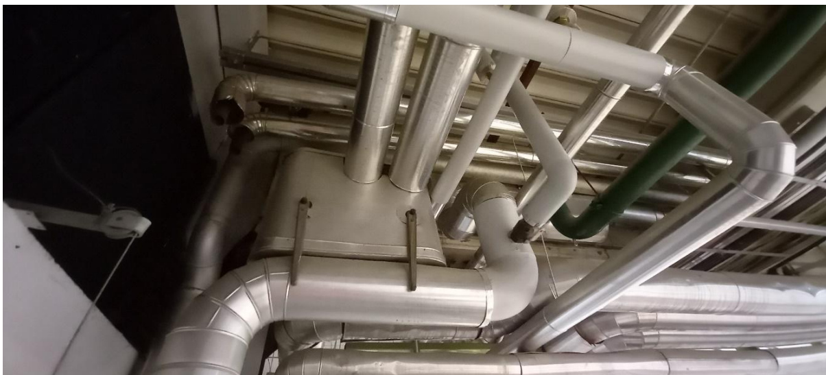
Kuva 2. Putkistorakenteita, joista osa on käyttämättömiä
