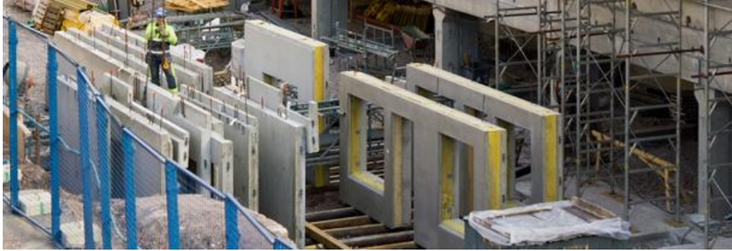
Kuva 1. Elementtien varastointia elementtipukkeihin. [Seppo Verho.]
