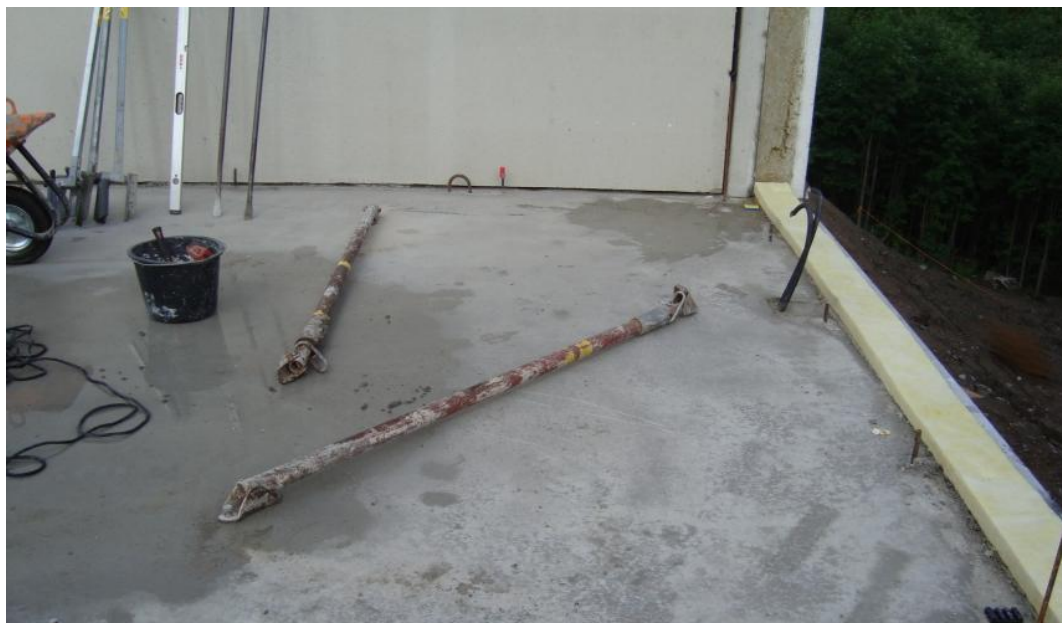
Kuva 3. Elementin asennuksen valmistelut käynnissä. [Pauli Saastamoinen.]
