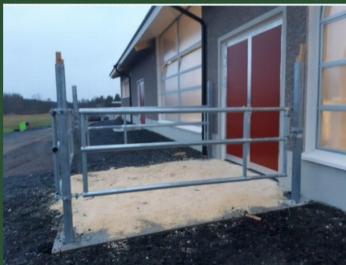
Eläimet tuodaan odottamaan eläinkuljetusautoa tuotantotilojen ulkopuolelle rakennettuun odotustilaan, mistä ne saadaan lastattua eläinkuljetusauton kyytiin.
