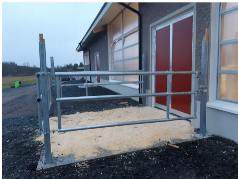
KUVA 9. Lastausalueelle on levitetty purua liukkauden estämiseksi (Snellman 2021)
