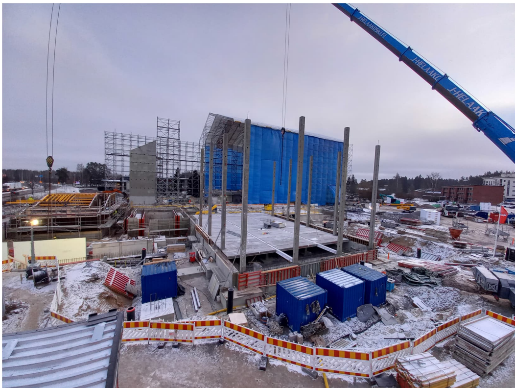
Kuva 10. Suojateltan pystytys Monion työmaalla
