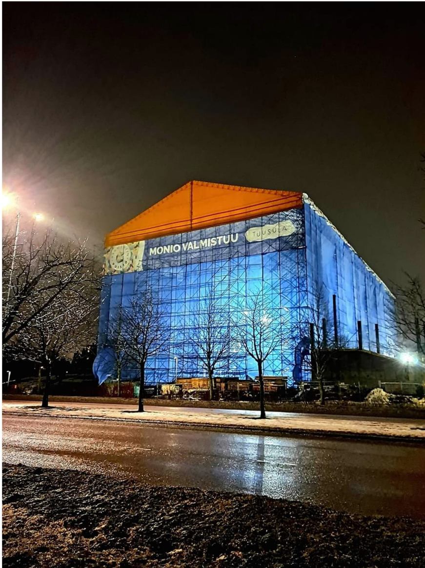
Kuva 17. Monion työmaa sääsuojan alla
