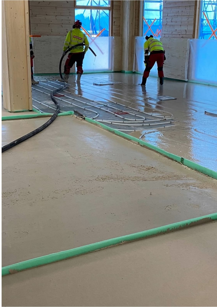
Kuva 7. Kipsivalu Monion työmaalla
