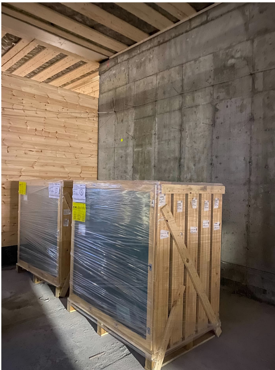
Kuva 18. Ikkunat varastoituna Monion työmaalla irti maasta tehdassuojissa
