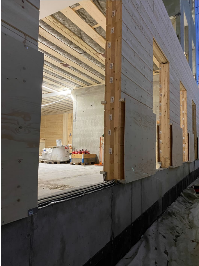
Kuva 14. Betonisokkeli hirsiseinän alla
