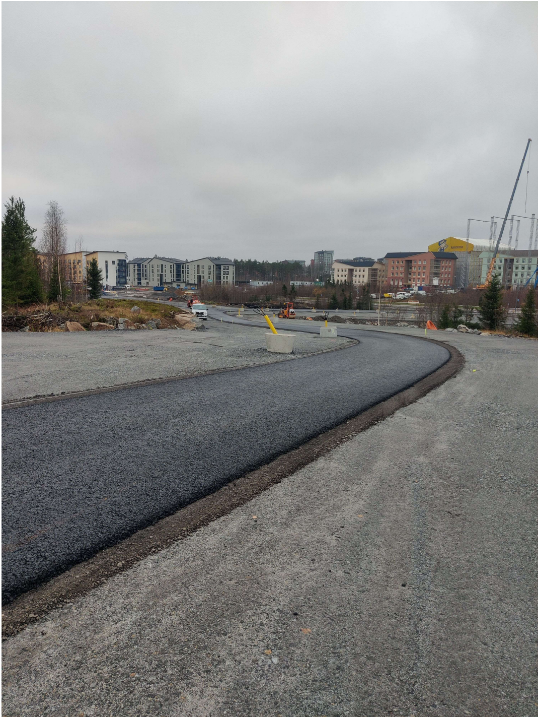
KUVA 3. Lähes valmis, turvallinen työmaa (Villgren, 2021)
