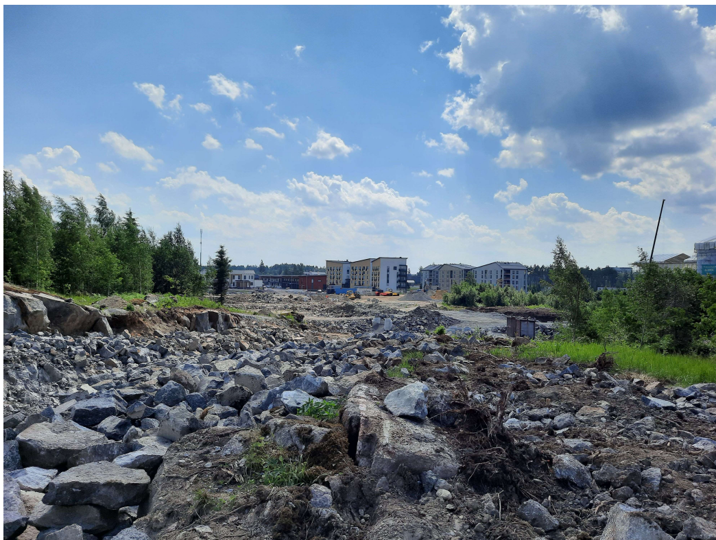
KUVA 1. Työn laajuutta ja louherakennetta
