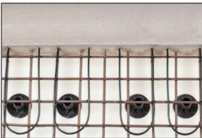
KUVA 17. Asennus betonimassaan (Pistesarjat Oy 2022)
