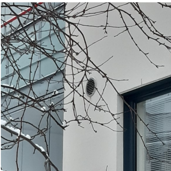
KUVA 2. Raitisilmasäleikkö kerrostalon ulkoseinässä
