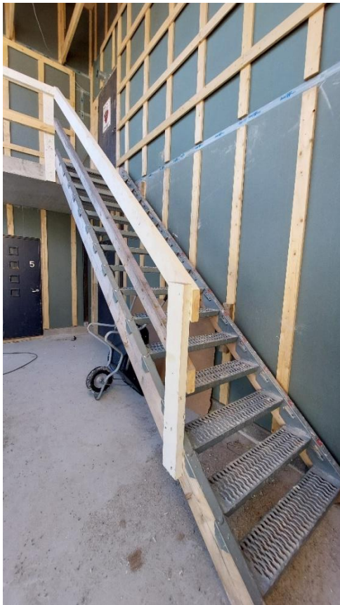
Kuva 2. Väliaikainen porraskerros kerrosten välillä
