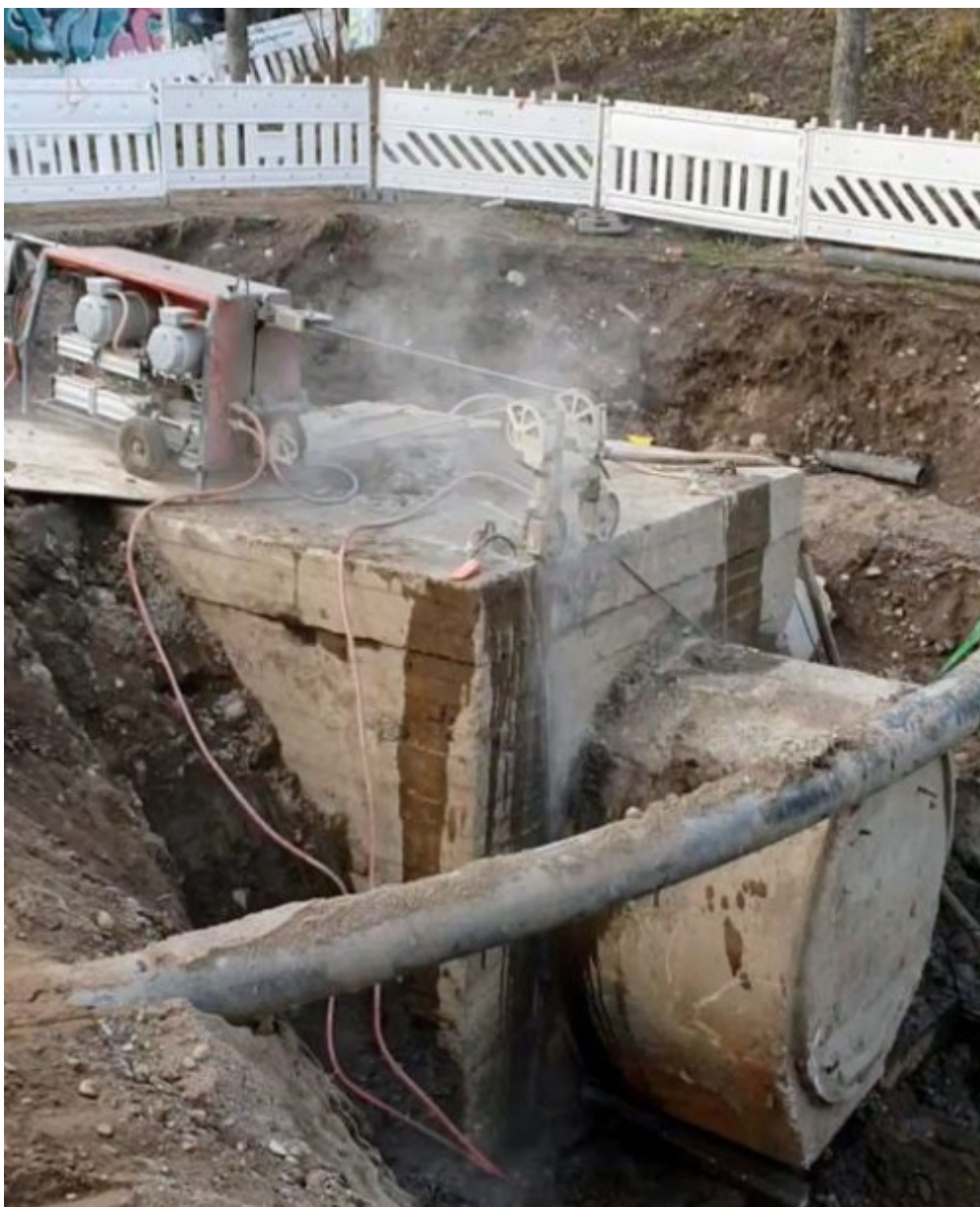
Kuva 10. Viemäriputken vaijerisahaus muutostöitä varten [17]
