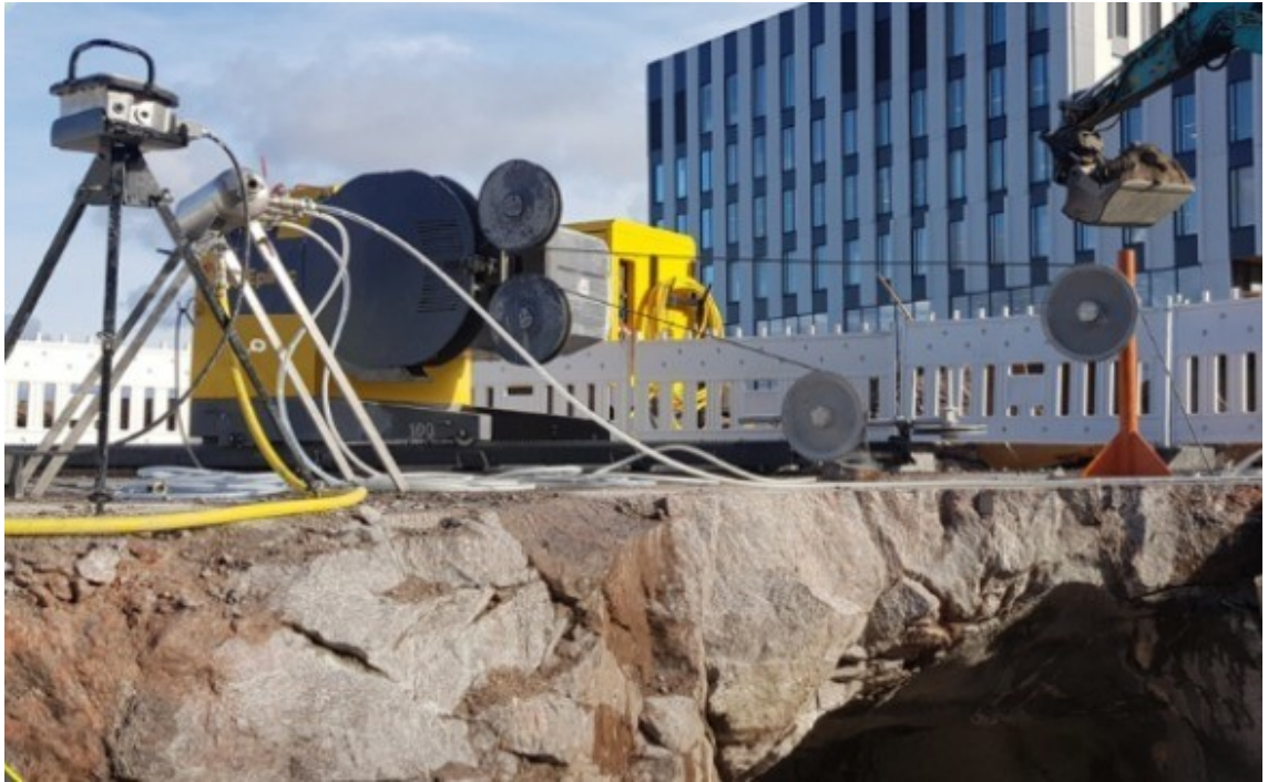
Kuva 19. Pystysuoran seinän sahaus Epicroc SpeedCut 100 -laitteella. [14]
