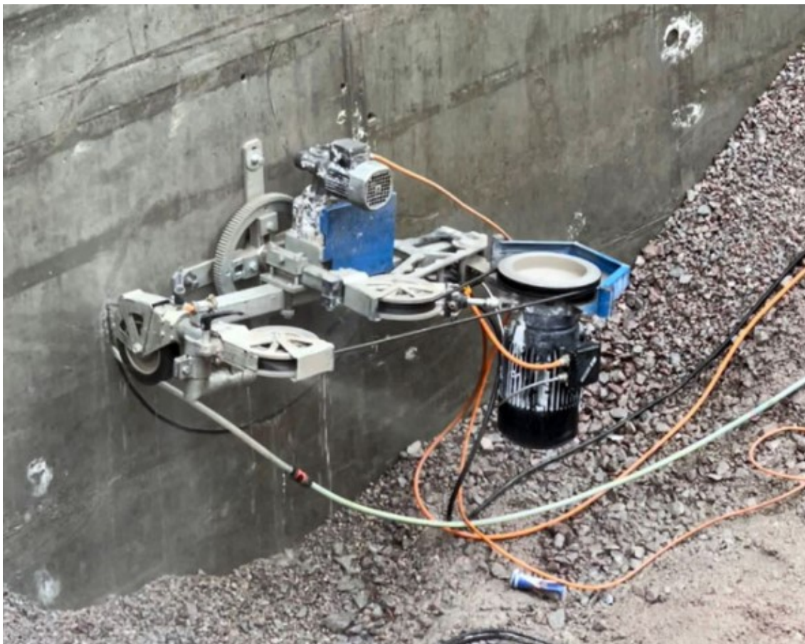
Kuva 5. Pyöreän 1200 mm reiän sahaaminen betoniseinään vaijeriharppisahalla. [15]
