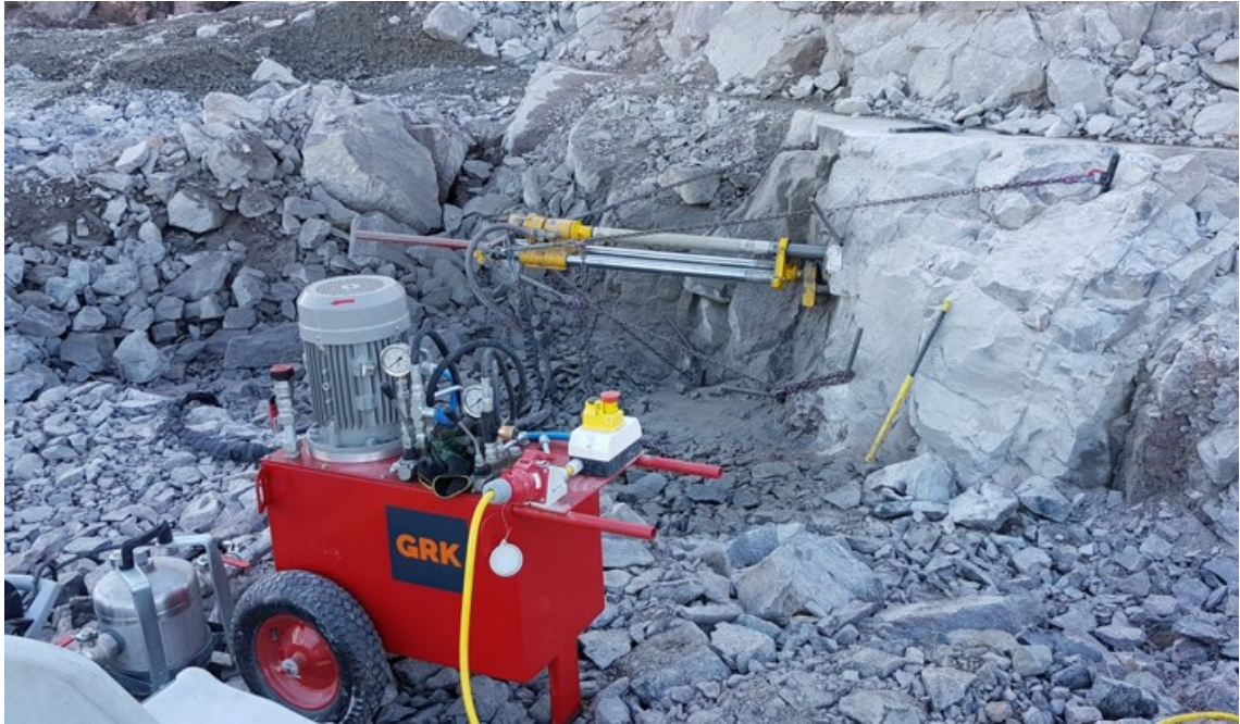
Kuva 20. Dazzini Machine PP90:llä vaakasuuntaisen ohjausreiän poraus. [14]
