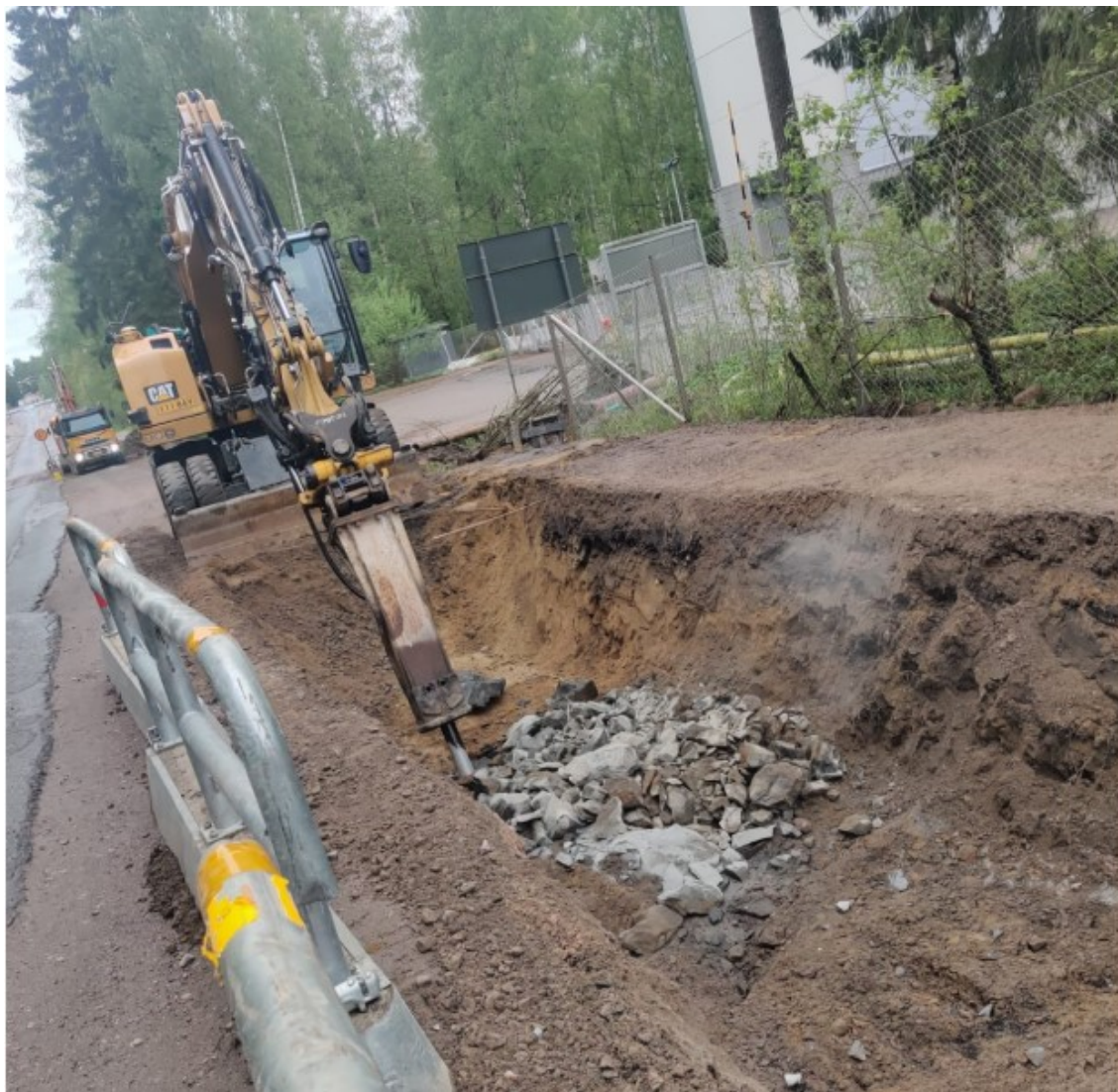
Kuva 2. Kalliokohouman tasaaminen iskuvasaralla putkikaivannossa
