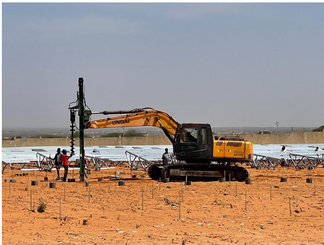
Kuva 5. Aurinkosähköpuistoa rakennetaan Mogadishun ulkopuolelle.
