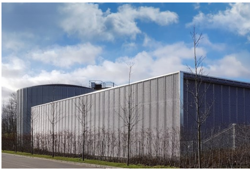
KUVA 10. Tårnbyn kunnan 2000 m 3 jäähdytysvesivarasto (20)
