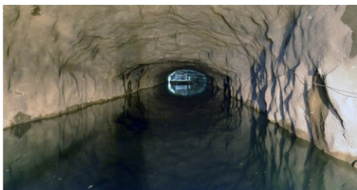
KUVA 11. Helenin Esplanadin jäähdytysvesivarasto kallioon louhittuna (21)
