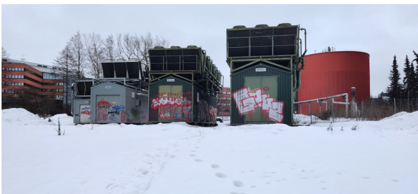
KUVA 16: Tampereen Sähkölaitoksen jäähdytyskontit (Antti Mikkonen)
