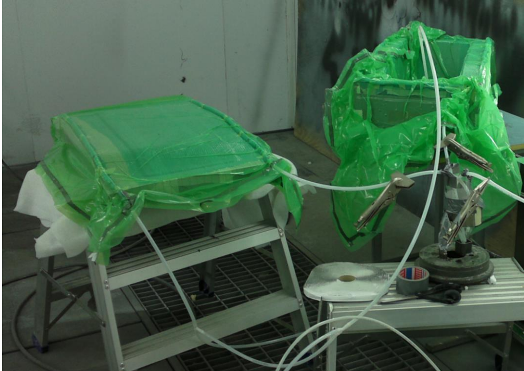
Kuva 18. Rungon osien injektointi
