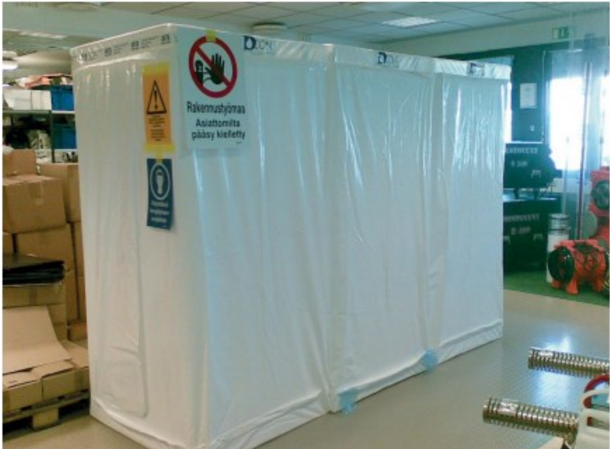
KUVA 7. Osastointimenetelmä asbestin purkutöissä (18)
