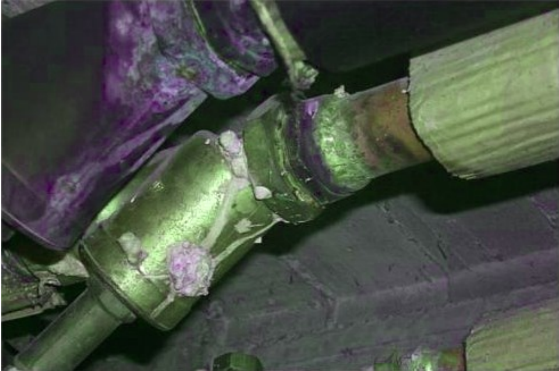
KUVA 6. Lämpöjohtoputkessa aaltopahviputkieriste, putkea vasten asbestihuopa
