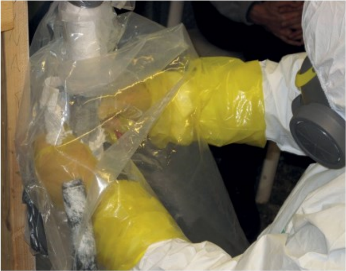
KUVA 8. Purkupussimenetelmä asbestin purkutöissä (18)
