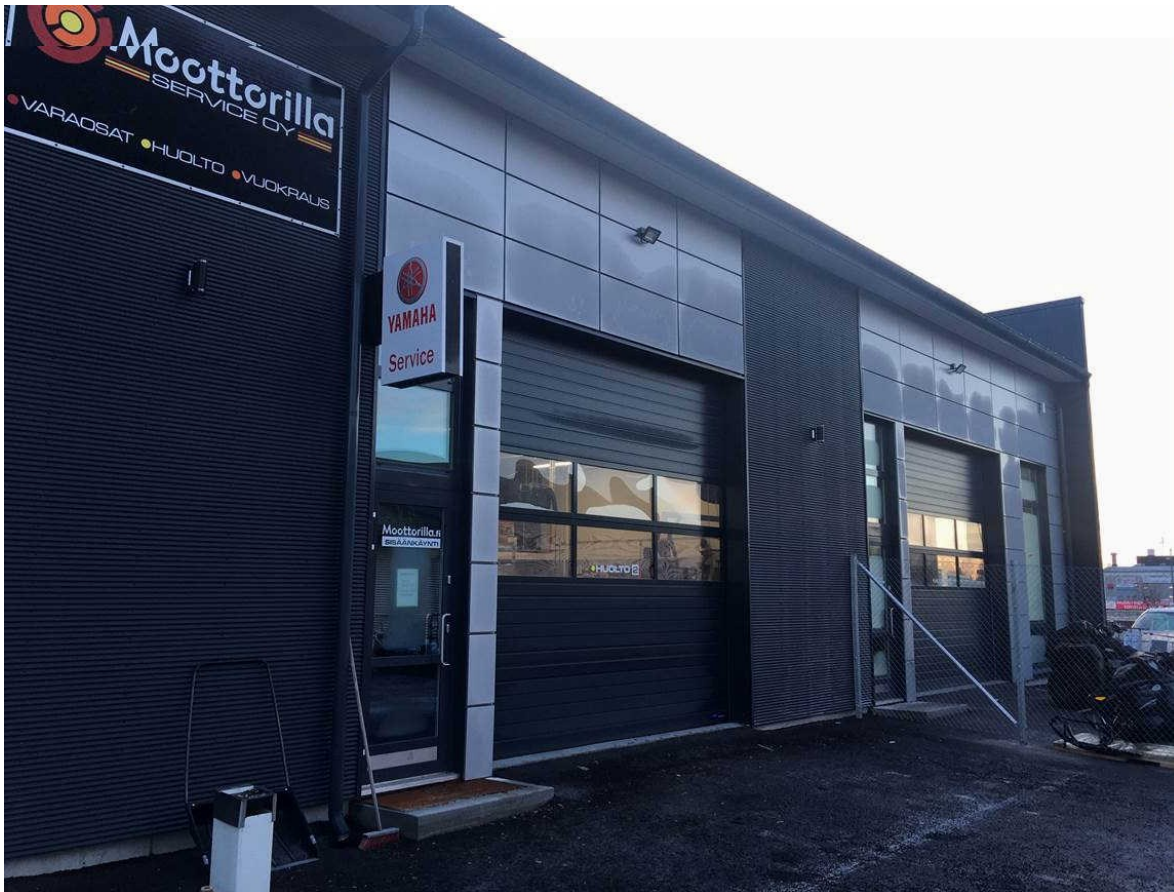
Kuva 1. Moottorilla SERVICE Oy:n tilat ulkoapäin (R. Ala-Nisula, 2021).
