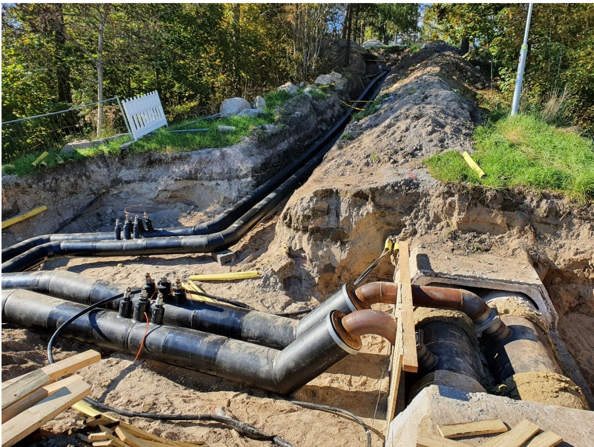
Kuva 2. DN200/2Mpuk-linjan liitos vanhaan DN600/Emv-siirtolinjaan (Korpela 2021)
