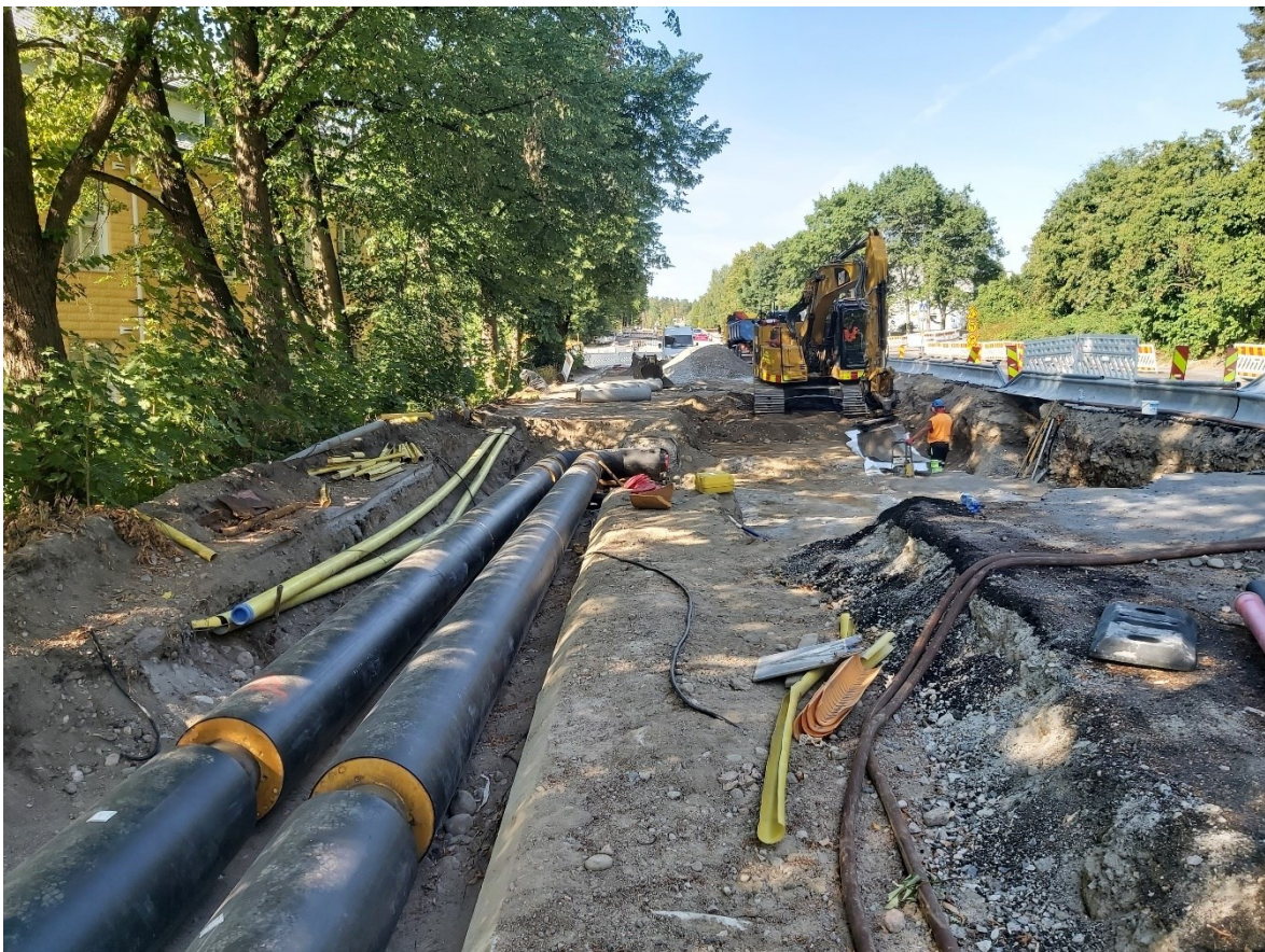
Kuva 4. DN300/2Mpuk-linjan jakelukeskeytyksen valmistelua
