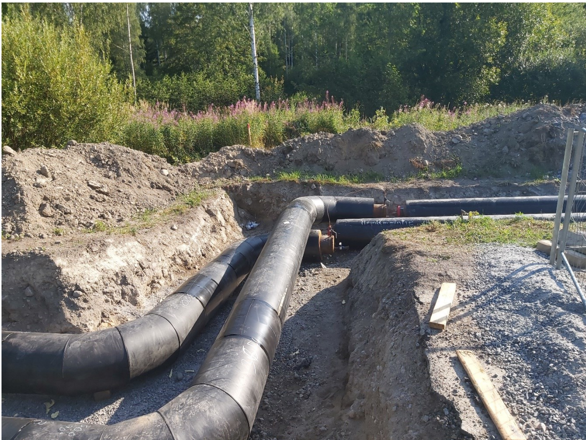
Kuva 3. DN300/2Mpuk-linjan kätisyyden vaihto
