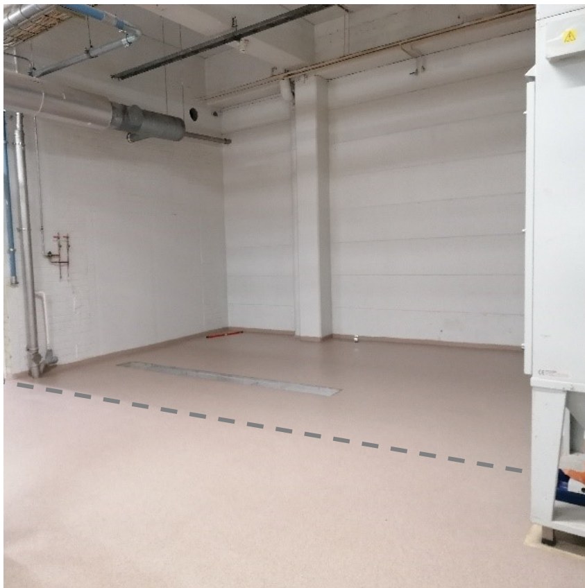
Kuva 5. Alueen laajennusvaihe. Katkoviivalla osoitettu purettu seinä.
