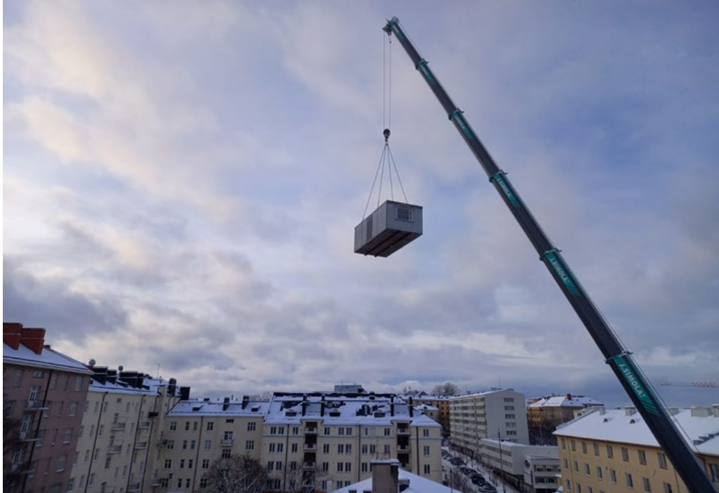
Kuva 2. Työmaailojen nostovaihe taloyhtiön sisäpihalle.
