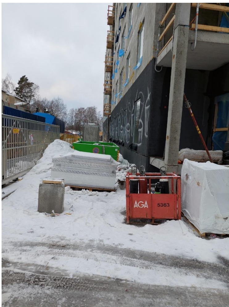
Kuva 24. Tahdin lounaan puolen julkisivu, johon telineet tulevat
