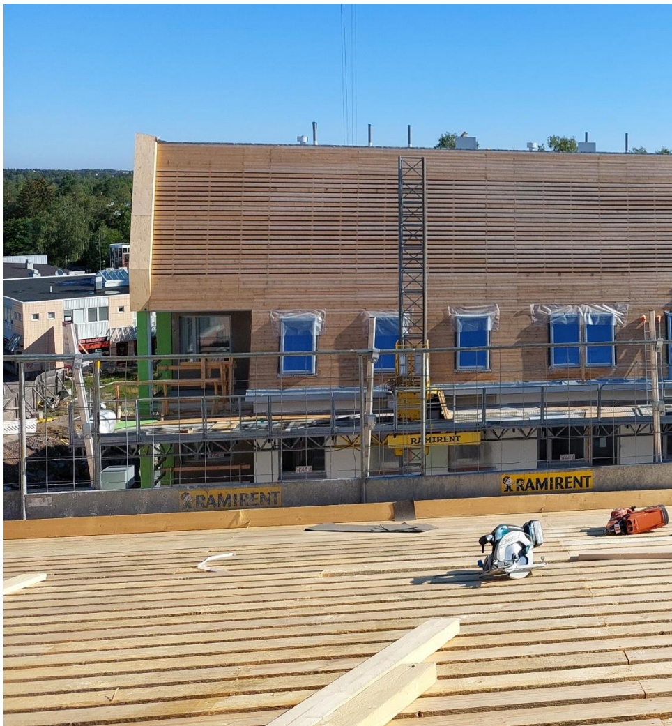
Kuva 7. Mastolavan käyttö työmaalla
