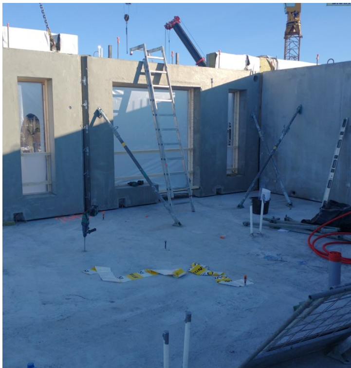
KUVA 2. Asennusaikainen betonielementin tuenta (Matikainen 2022)
