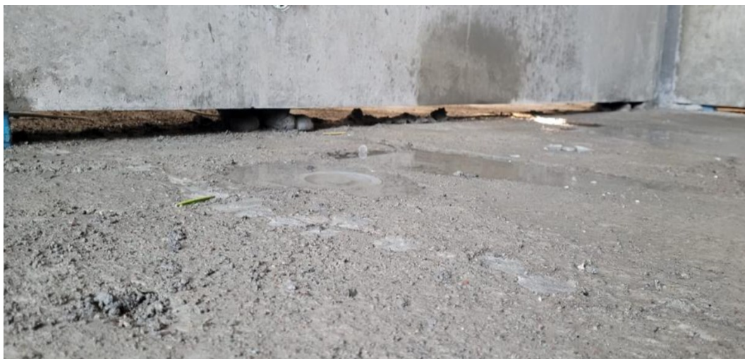
KUVA 9. Lattian ja seinäelementin välistä puuttuu alusmassa. Yritys D (kuvan julkaisulupa opinnäy- tetyön tekijällä)
