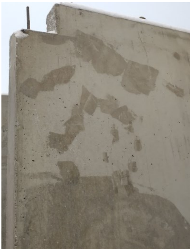
KUVA 8. Korjattu betonielementti Yritys C (kuvan julkaisulupa opinnäytetyön tekijällä)
