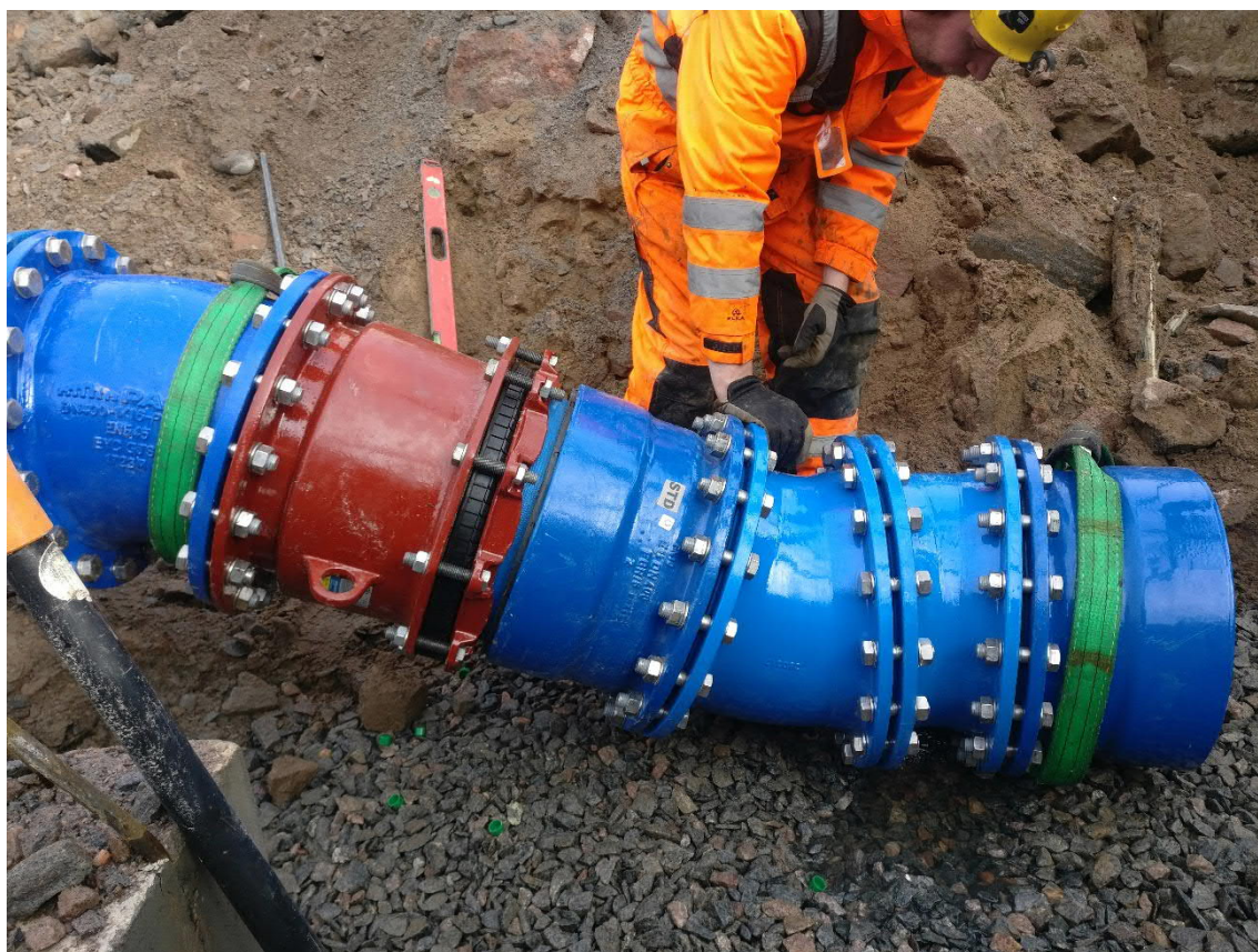
Kuva 13. Multi/Joint DN400 laippaliitin, laippakulmia ja E-kappaleita Telakkaranta Helsinki (Kemppainen 2019)
