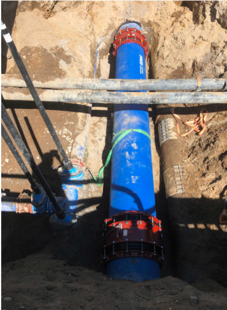
Kuva 15. Multi/Joint-jatkoliitin DN600 Kaivoksela-Myyrmäki runkovesijohto (Kempainen 2020)
