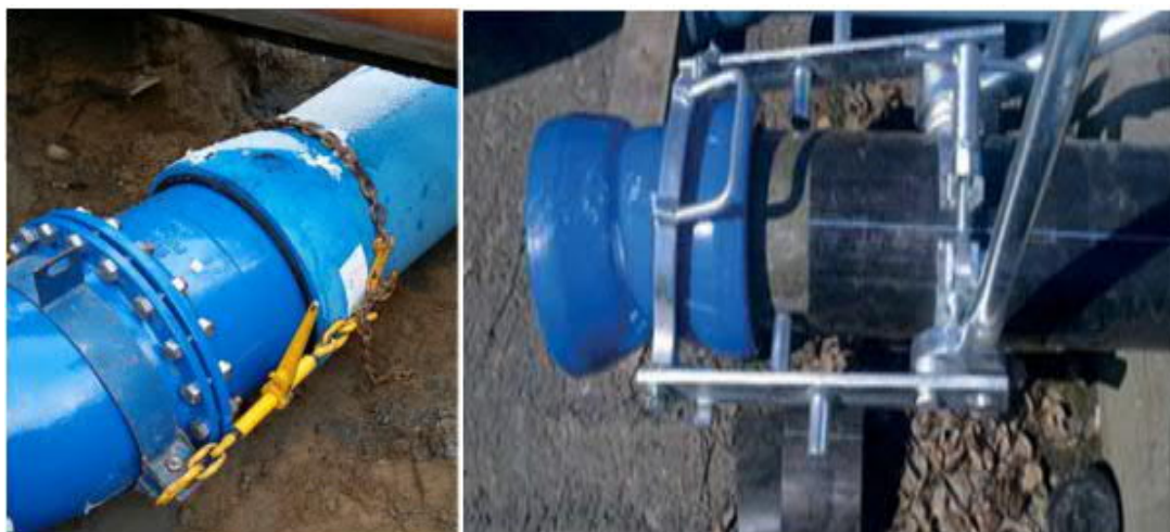
Kuva 25. Kulmakappaleen asennus taljoilla ja asennustyökälulla. (Saint-Gobain 2020)
