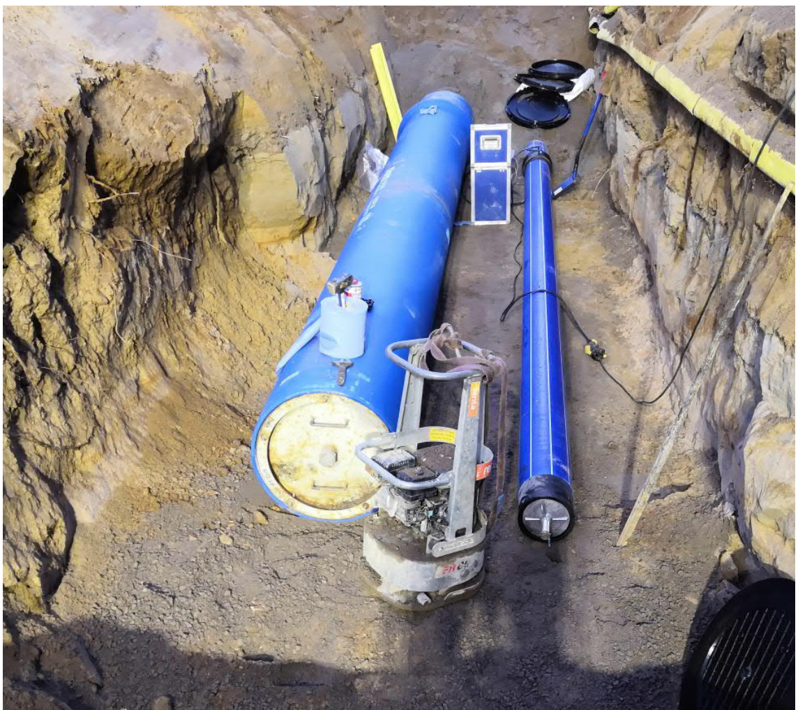
Kuva 5. DN600 Natural Universal Tyton ja Standard Vi putki (Kempainen 2020)
