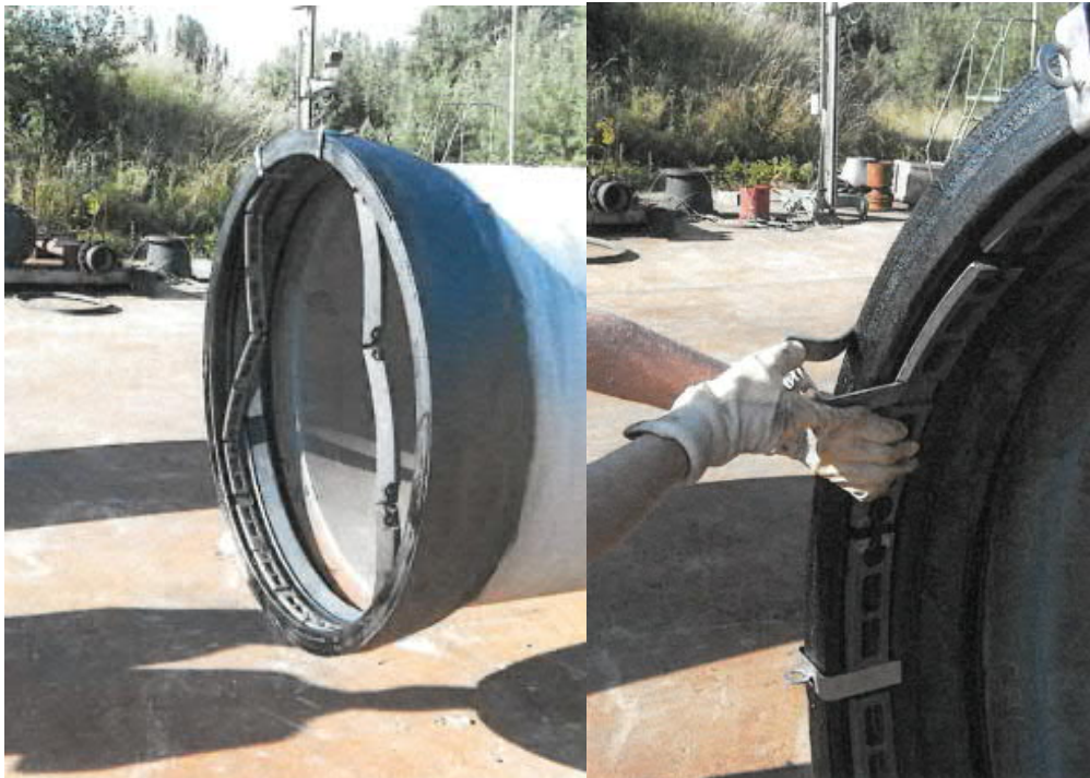
Kuva 32. Segmenttilukkorengaan asennus hakasilla. (Saint-Gobain2020)
