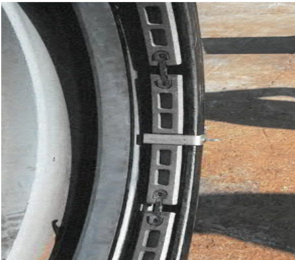
Kuva 33. Segmenttilukkorengas paikallaan kammiossa hakasilla. (Saint-Gobain 2020)
