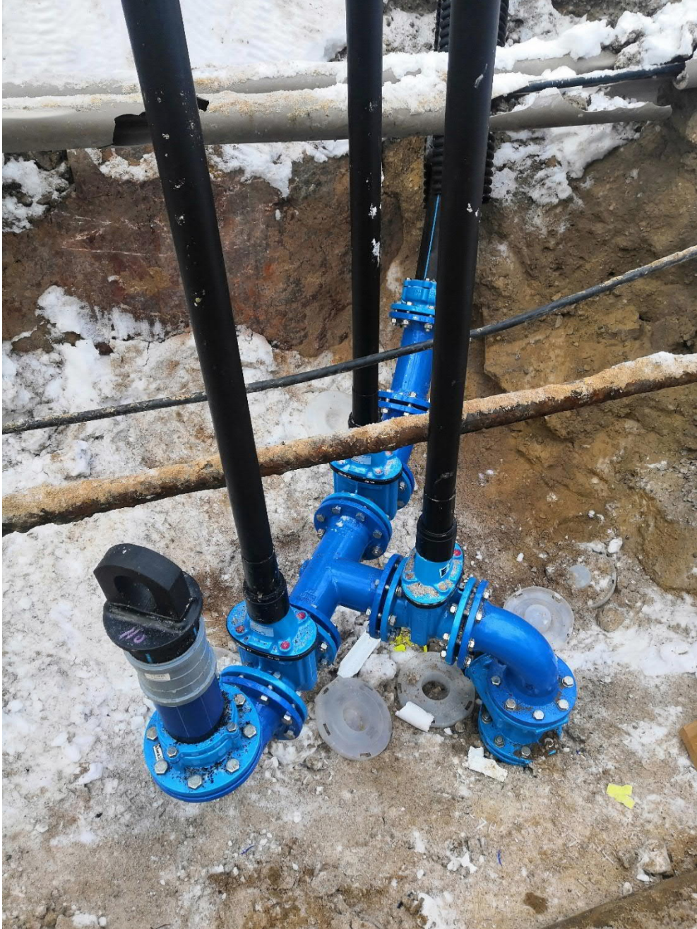
Kuva 10. DN150-150 t-haara, sulkuventtiilit ja kulmakappaleita (Rainis 2022)
