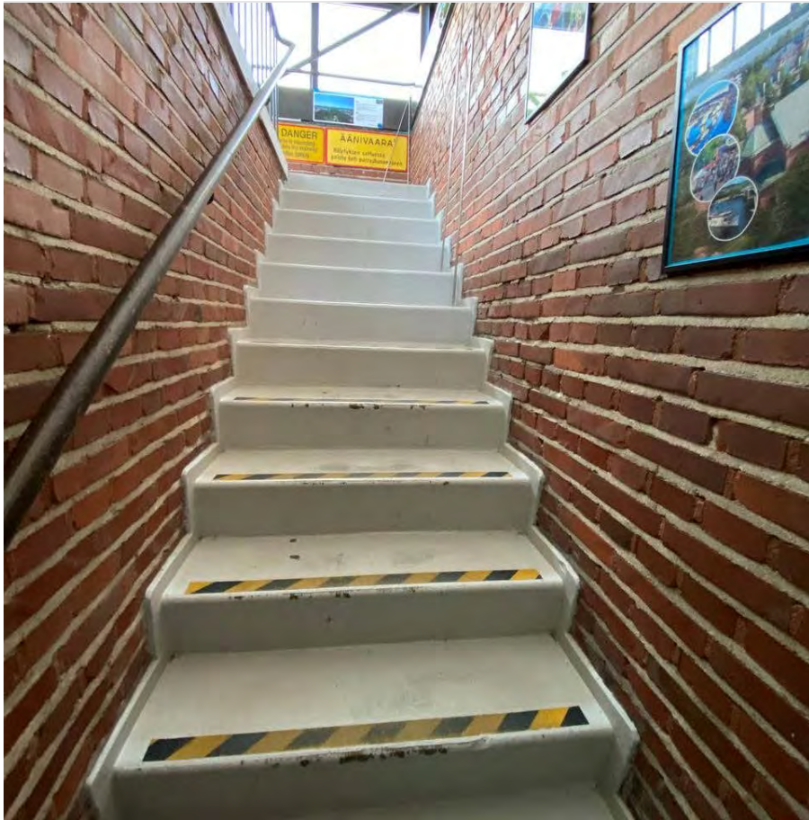
Kuva 19. Portaikko näkötornin ylämpään kerrokseen (kuva: JAMKin opiskelijaryhmä)
