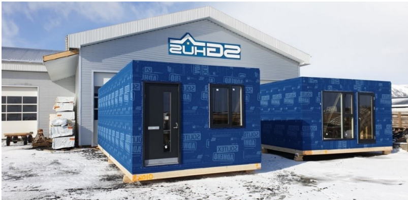
Kuva 13. Tuulensuojakankaan käyttö seinissä (Sigtryggur Ari, 2020).
