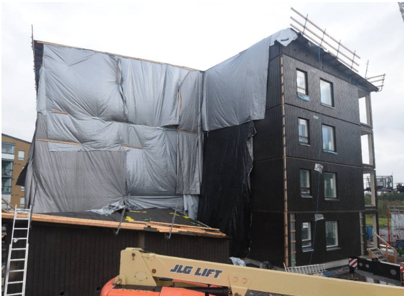
Kuva 7. Rantapuiston asennusaikainen suojaus
