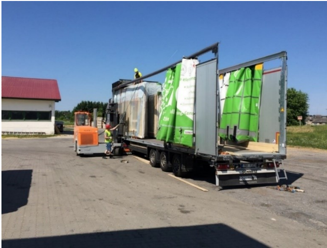
Kuva 15. Moduulin kuljetus suojapeitteisellä rekalla (Puuinfo, 2020).
