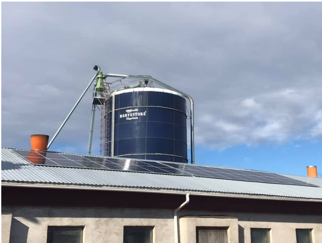
Kuva 8. Aurinkopaneelit asennettu itälapeelle (Kari Hemminki)
