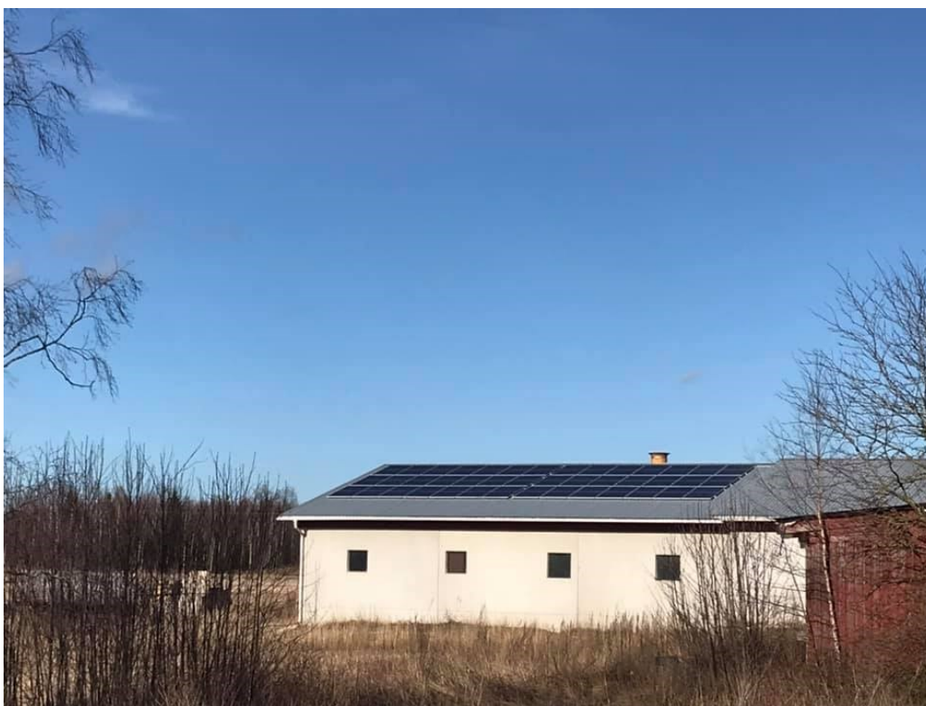
Kuva 9. Aurinkopaneelit asennettu etelälapeelle (Kari Hemminki)
