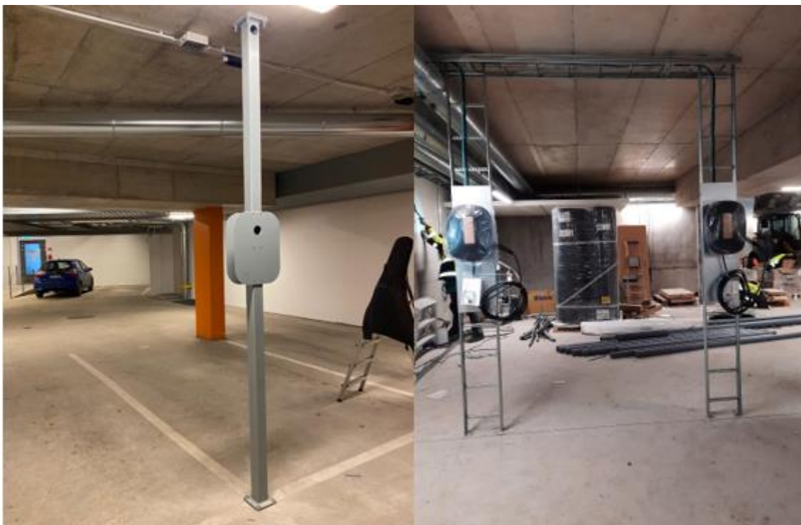
KUVA 25. Eri vaihtoehtoja latausasemien kiinnittämiseen autohallikohteissa
