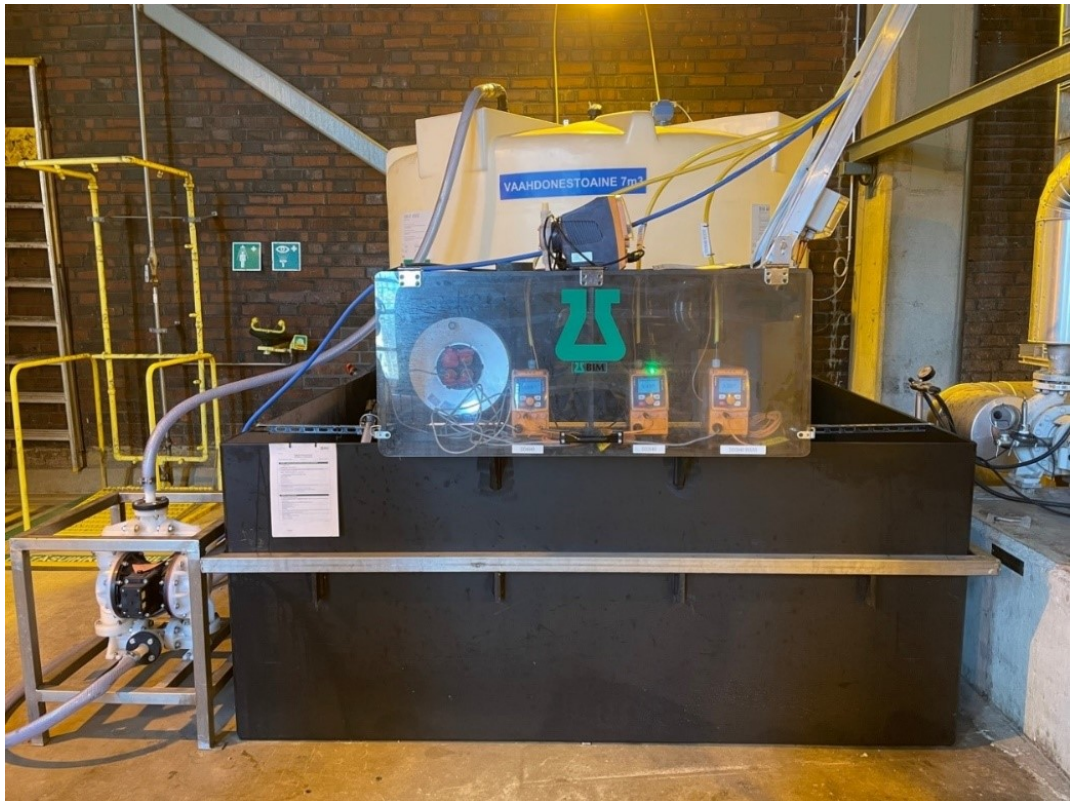
Kuva 13. Silikonipohjaisen vaahdonestoaineen annostelulaitteisto (Monthan 2022)
