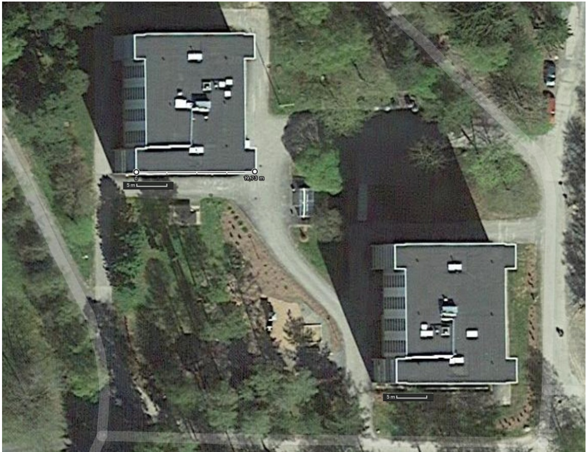
KUVA 14. Taloyhtiön rakennusten katot Google Maps -satelliittikuvassa.
