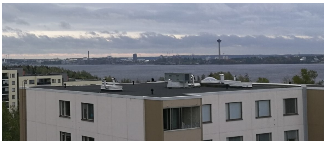
KUVA 15. Taloyhtiön A-talon katto kuvattuna B-talon katolta.
