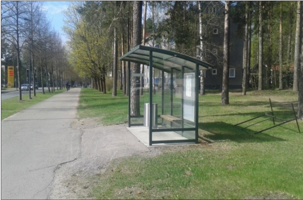
Kuva 14. Vuoksenniskantie 48 E pysäkki.
