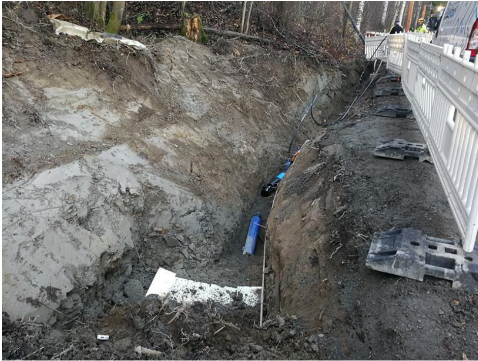
Kuvio 6. Valokuva työmaalta
