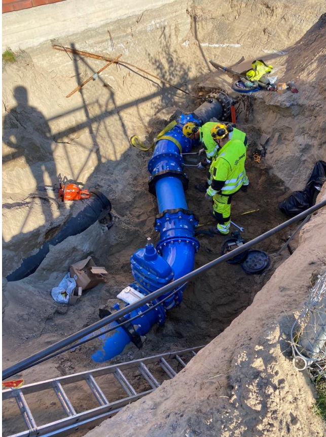
Kuvio 7. Valokuva työmaalta
