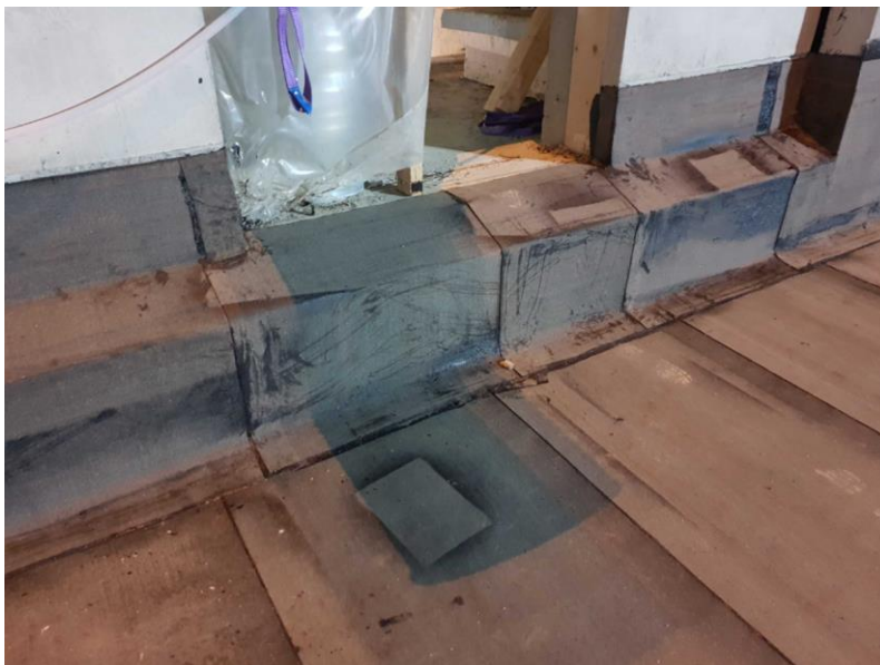
KUVA 15 Bitumikermin nosto seinälle.
