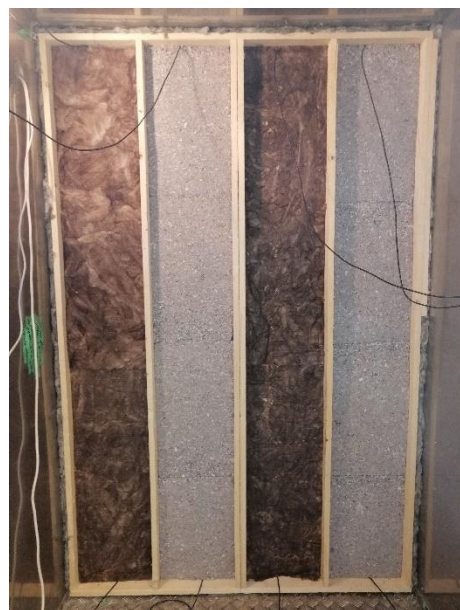
Kuva 11. 100 mm eristeet asennettuina seinärunkoon.
