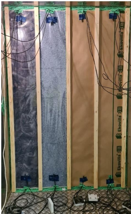
Kuva 14. Mittausantureiden höyryn- ja ilmansulun sisäpuolella
