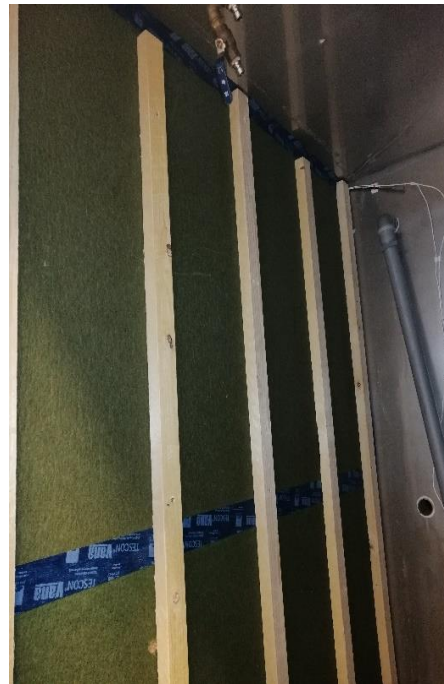
Kuva 15. Koolaus seinän ulkopuolella.
