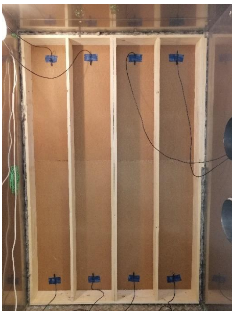
Kuva 10. Mittausantureiden paikat tuulensuojalevyn sisäpinnassa.
