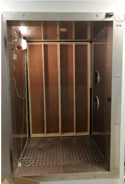
Kuva 8. Seinän runko sääkaapissa.
