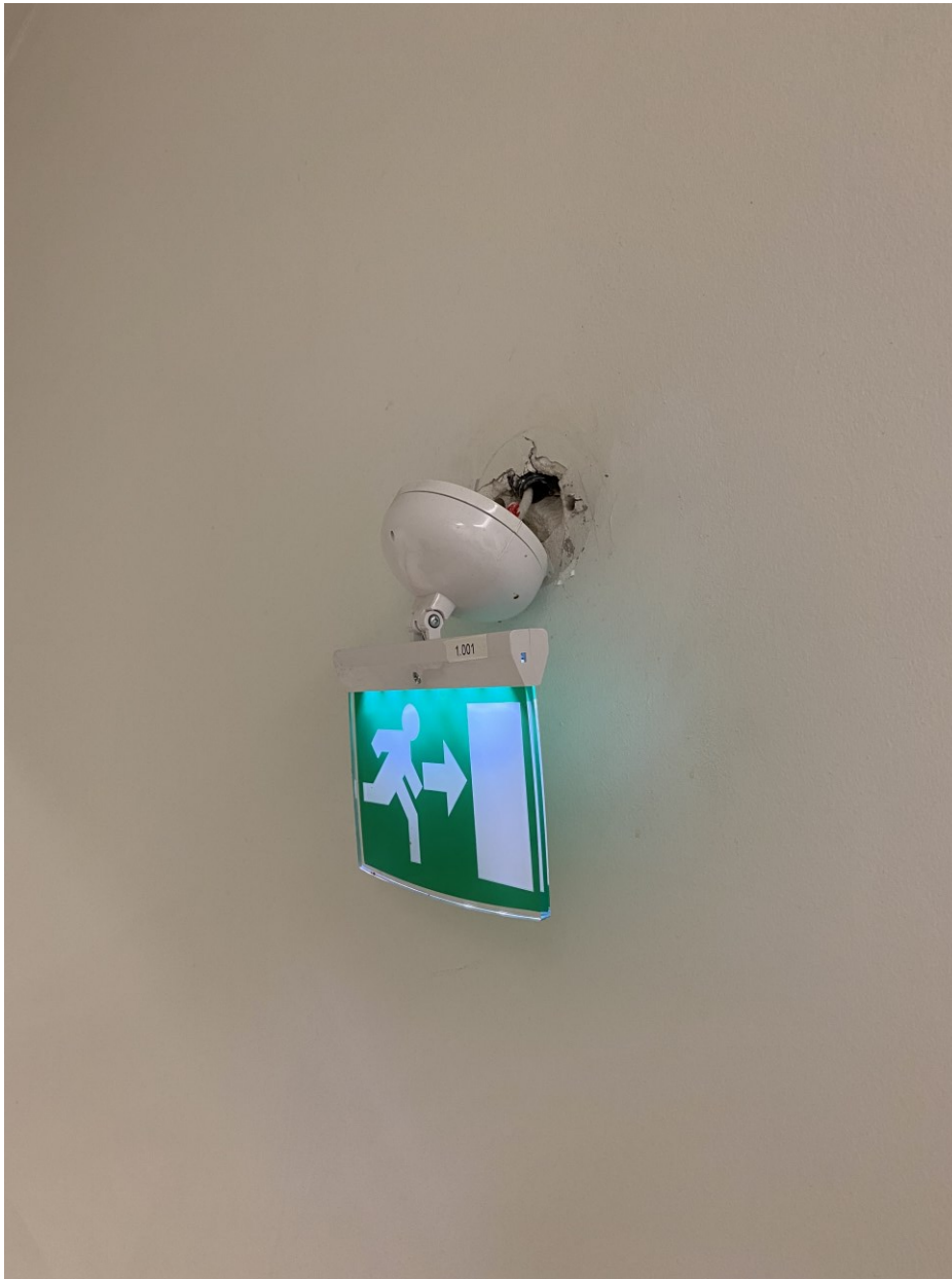
Kuva 8. Esimerkki tyypillisestä opastevalosta, joka on irronnut seinäkiinnikkeistä. [7.]
