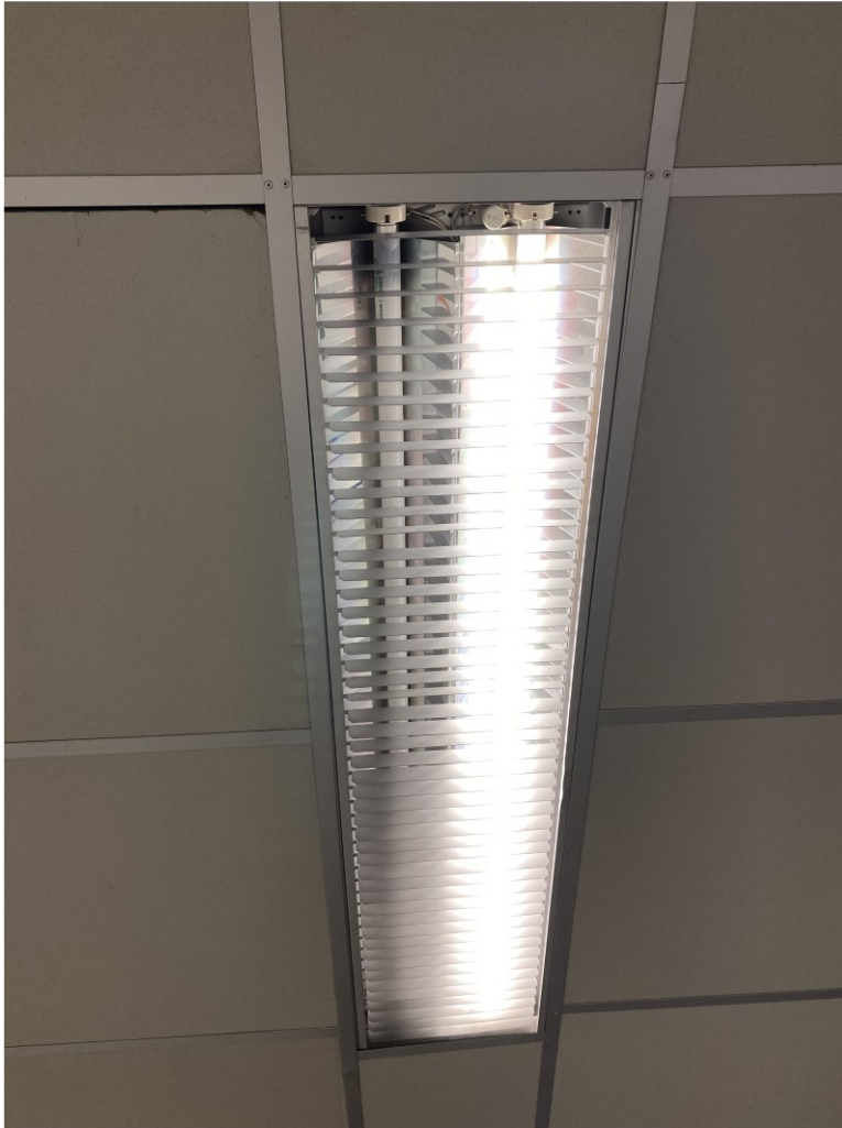
Kuva 4. Esimerkki vanhoista loisteputkista, joista toinen loisteputki ei toimi. [7.]
