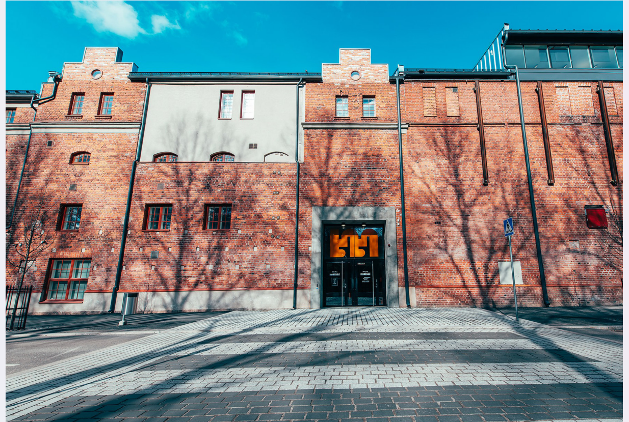
Kuva 29. Malskin julkisivu (Malski 2022)
