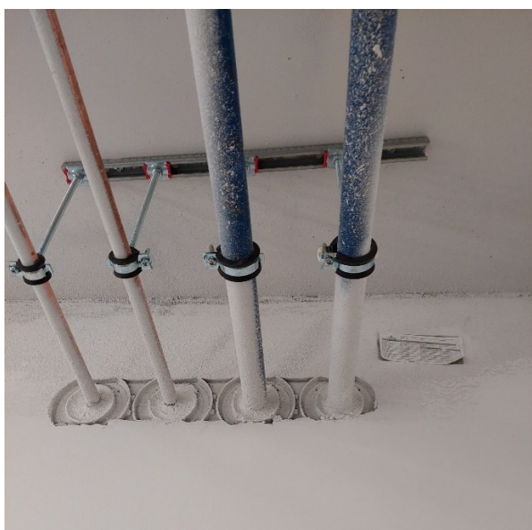
KUVA 5. Valmiit palokatkot (Räsänen, 2022)
