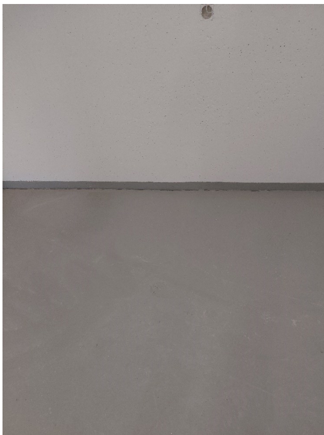
KUVA 1. Lämmönjakohuoneen lattia ja seinät maalattu (Räsänen, 2022)
