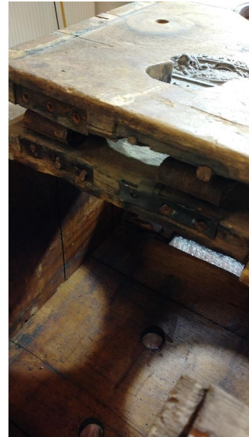
Kuva 164 Yksityiskohta ilman ulostuloluukun saranoista nahkaa vaurioittavan osan poiston jälkeen (Ikonen 2022)
