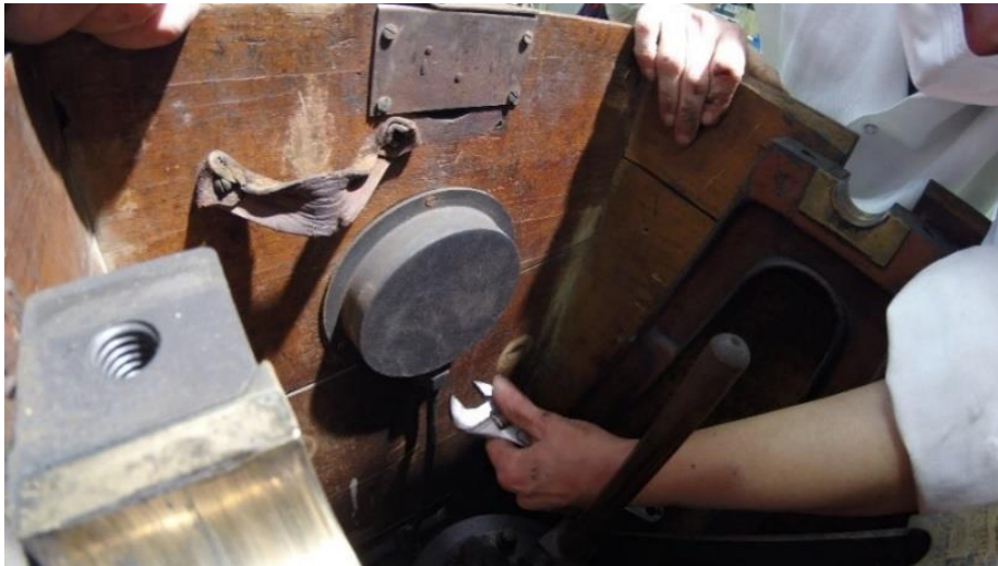
Kuva 54 Pumppukoneiston irrotusta (Strandell 2021)
