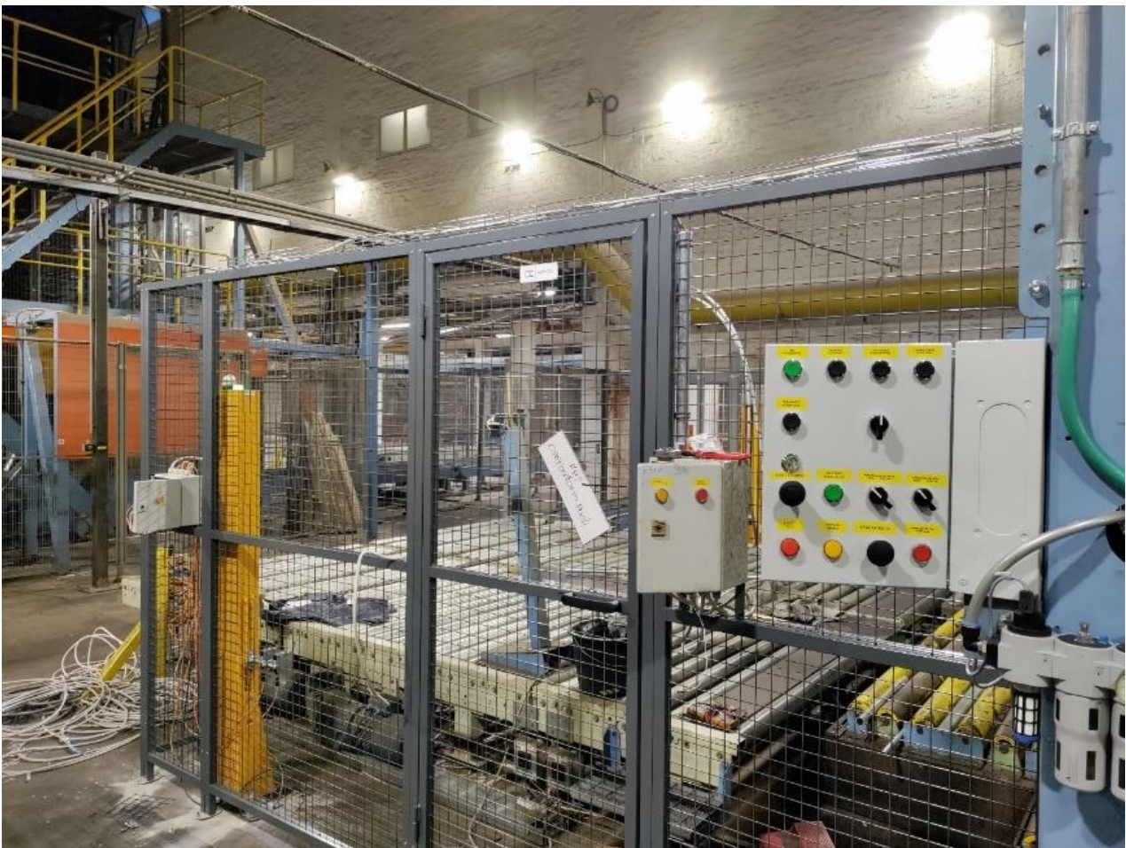
Kuvio 44 OK1, OK2 ja OK4 paikalleen asennus ja kaapelointi
