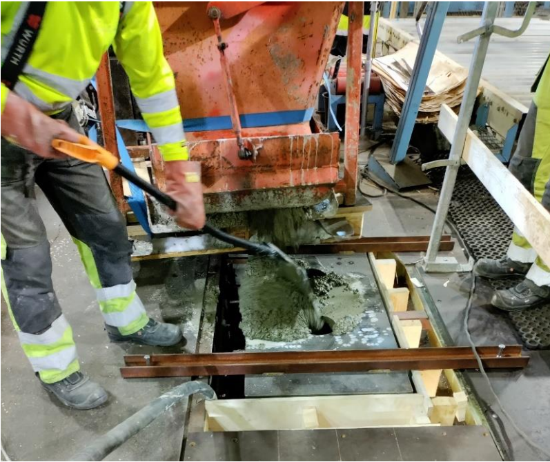
Kuvio 28 Betonijalkojen valu
