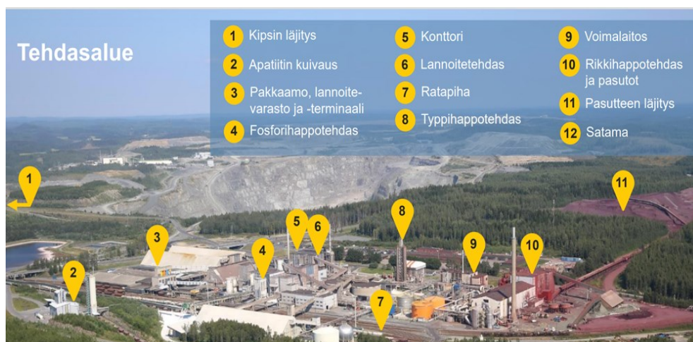
KUVA 2. Yleiskuvaus Siilinjärven tehdasalueesta (Yara 2022.)
