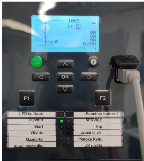
KUVA 3. Schneider P3U30 (Turunen, 2022)
