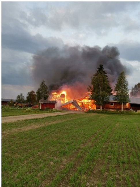
KUVA 3. Puurakenteinen tuotantorakennus tulessa (Huuskonen 2021b)
