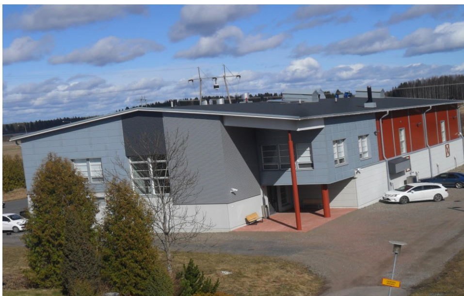
Kuva 1. HAYO talotekniikan oppimisympäristö
