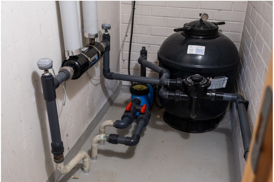
Kuva 19. Pari vuotta sitten uusittu laitetila, alkuperäiset rakenteissa kulkevat kupariputket lattia-rajassa [18]
