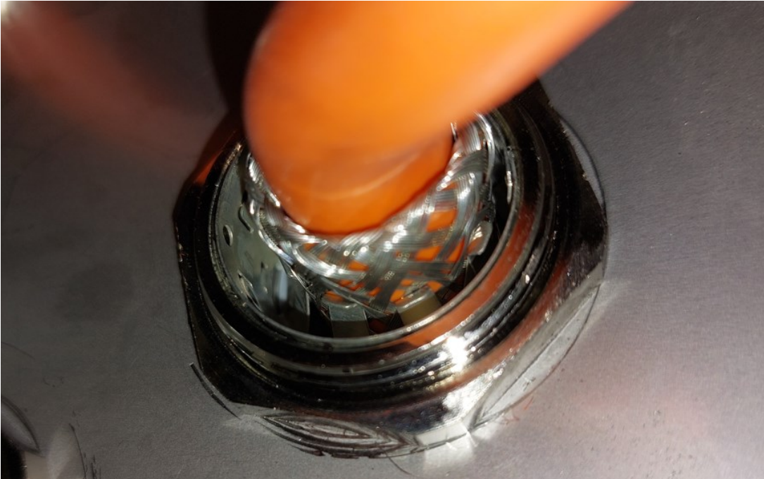
KUVA 7. Kaapelin vieminen koteloon EMC-holkkitiivisteiden läpi
