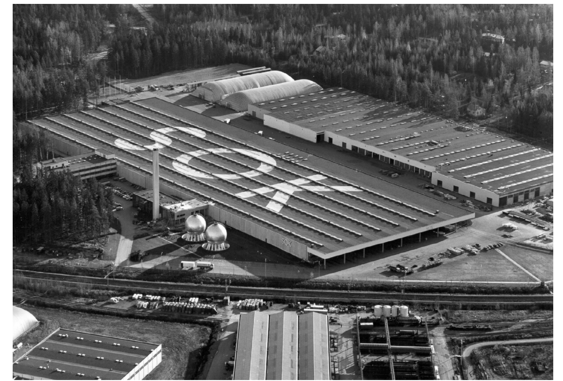
Kuva 21. Vanha SOK:n keskusvarasto vuonna 1975 (Keran hallit)
