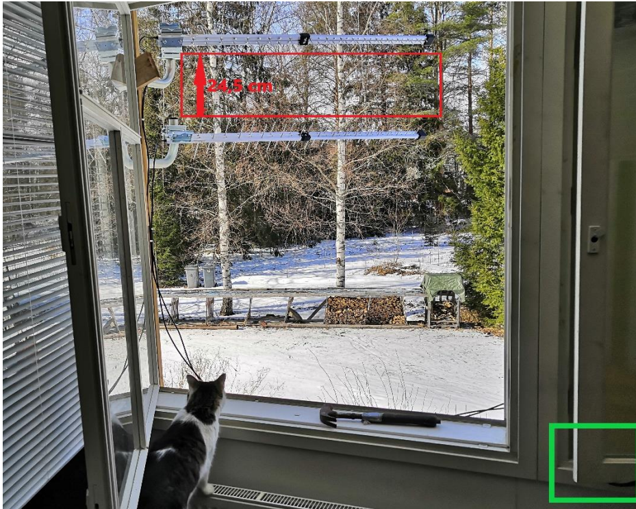
Kuva 40. Suunta-antennit asennettuina MIMO-kytkennällä
