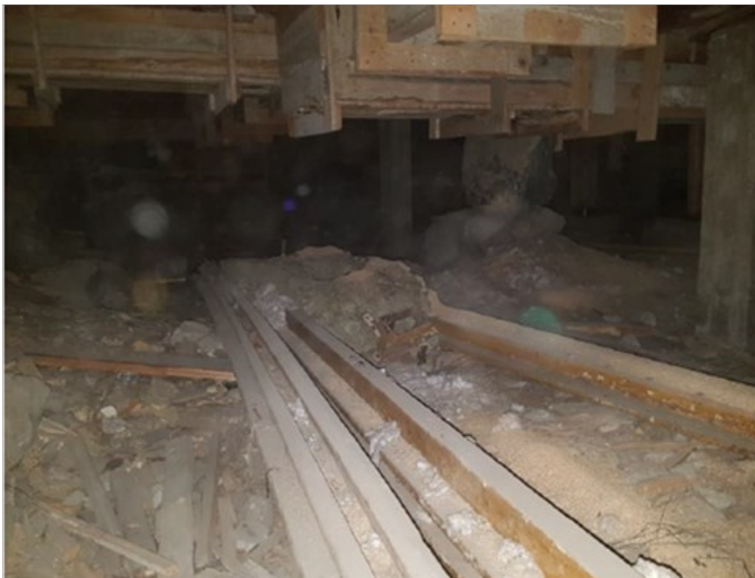
KUVA 15. Rakennuksen B-osan alapohjaan on jätetty orgaanista ainetta rakennusvaiheessa. (Kuopion kaupunki, Opinnäytetyön tausta-aineisto 07 TUTKIMUKSET_KARTOITUKSET).
