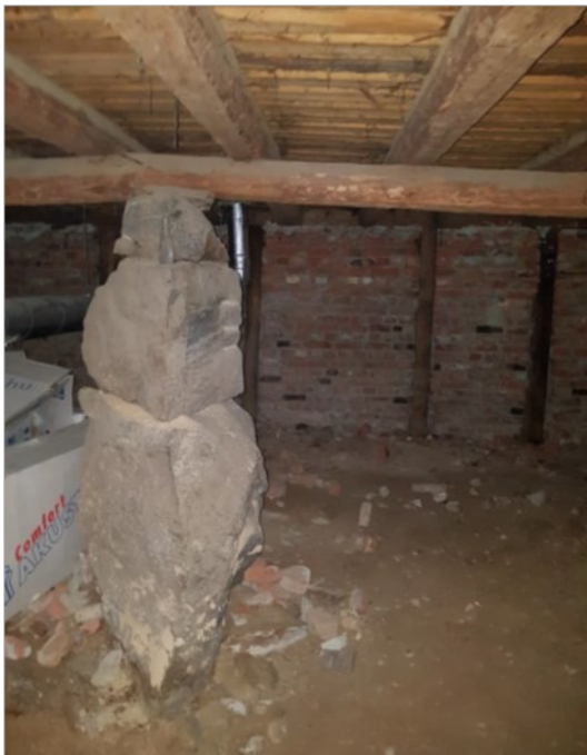
KUVA 13. Rakennuksen B-osan alapohjan kantavia kivipilareita ja mahdollisia entisiä uuninperustuksia. (Kuopion kaupunki, Opinnäytetyön tausta-aineisto 07 TUTKIMUKSET_KARTOITUKSET).
