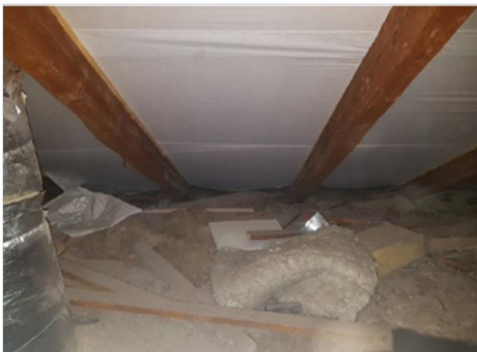
KUVA 18. B-osan yläpohjassa on eristeenä vaihtelevasti ainakin puhallusvillaa sekä hiekkaa ja sammalta. Yläpohjaan on jätetty eriste- ja rakennusmateriaaleja. Vesikatto on uusittu v.2006 ja samalla asennettu aluskate. (Kuopion kaupunki, Opinnäytetyön tausta-aineisto 07 TUTKIMUKSET_KARTOITUKSET).
