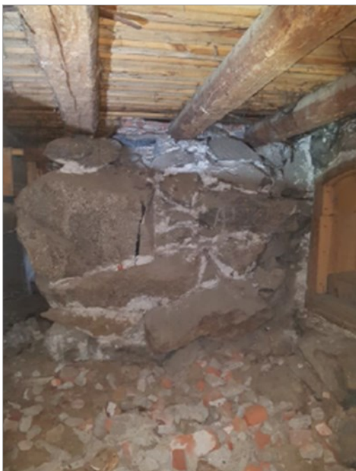
KUVA 14. Rakennuksen B-osan alapohjan kantavia kivipilareita ja mahdollisia entisiä uuninperustuksia. (Kuopion kaupunki, Opinnäytetyön tausta-aineisto 07 TUTKIMUKSET_KARTOITUKSET).
