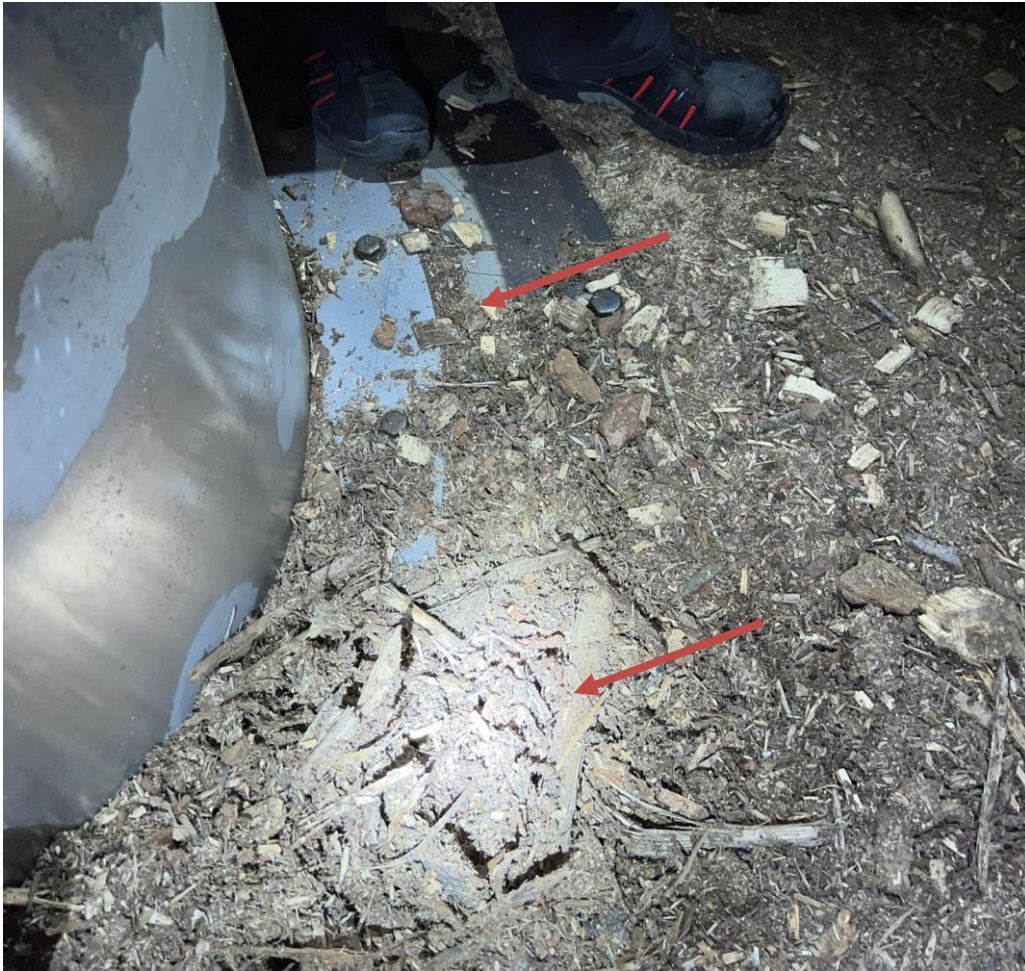
KUVA 23. Pohjalle kynnyksiin tarttuneet suuret polttoainekokkareet
