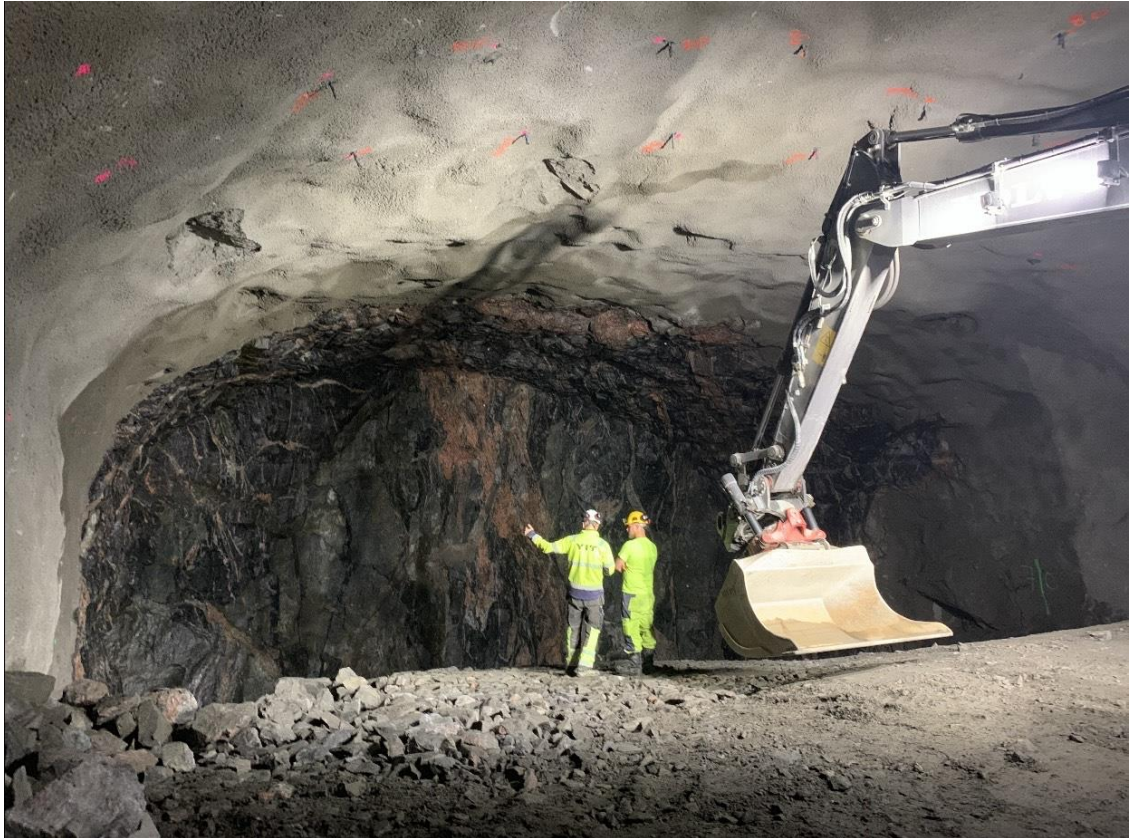
Kuva 1 Tunneliprofiili Henriksdalin jätevedenpuhdistamon työmaalta. [15.]
