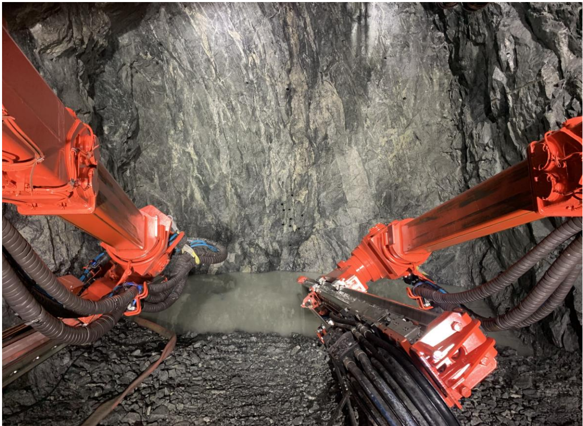
Kuva 2 Tunneliprofiili porajumbon edestä kuvattuna. [15.]
