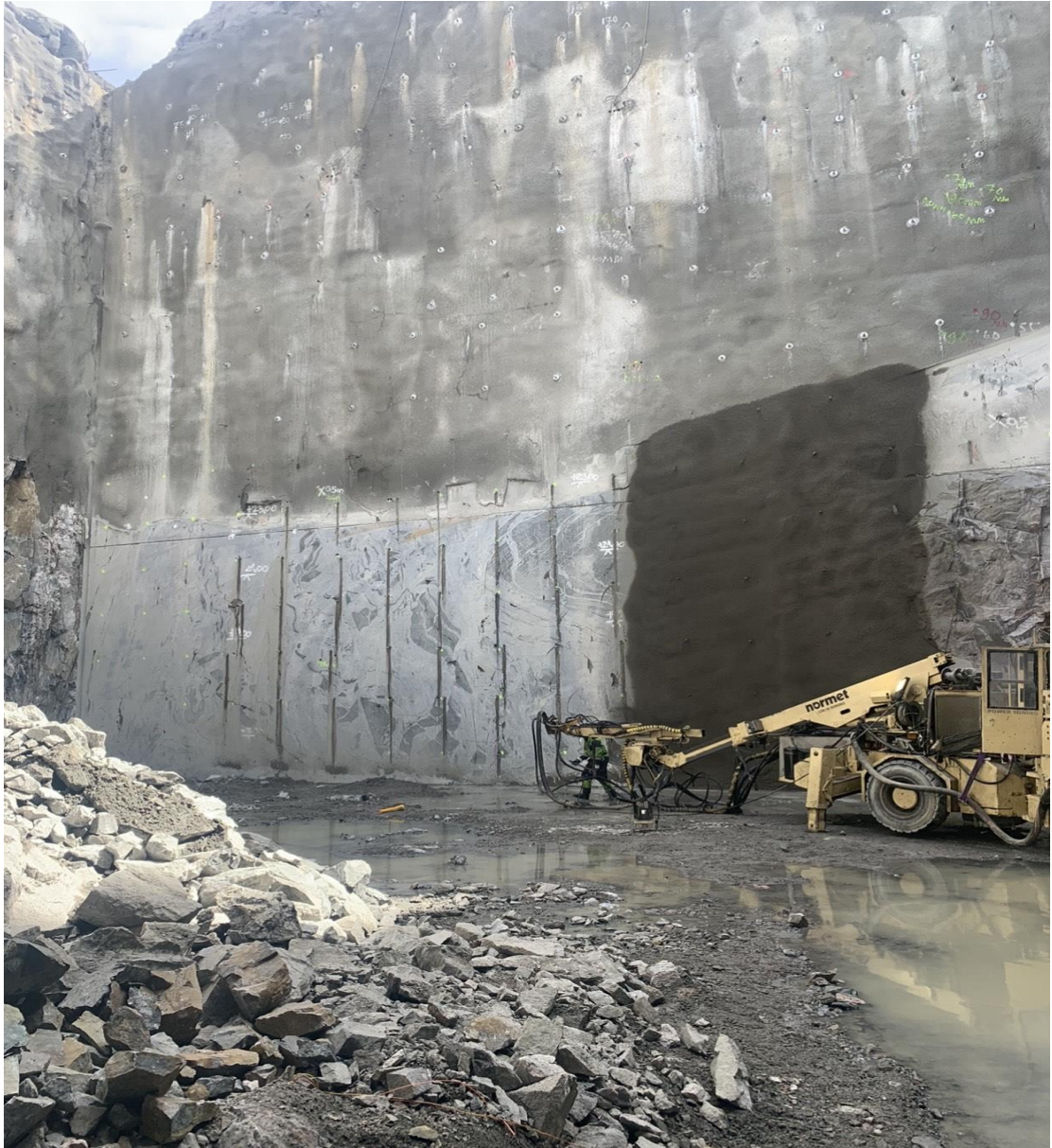
Kuva 3 Ruiskubetonointia vaijerisahattuun kallionpintaan Henriksdalin jätevedenpuhdistamon työmaalta. [15.]
