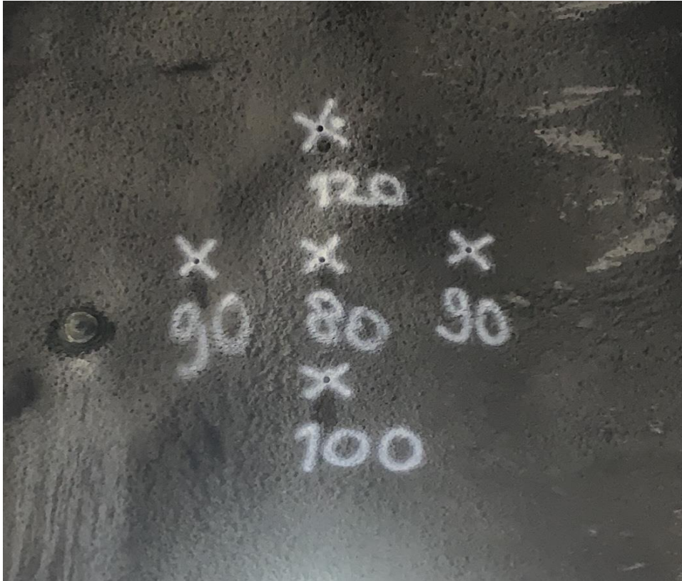
Kuva 6 Paksuusmittaus kovettuneeseen betoniin Henriksdalin työmaalla. [15.]
