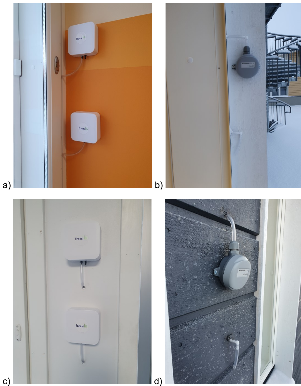
Kuva 2. a) Paine-eron anturit asennettu ikkunakarmista. b) Paine-eron mittaus- letkun asennus rakennuksen ulkopuolella). c) Paine-eron anturit asennettuna ul- koseinän läpi. d) Paine-eron mittaus letkun asennus rakennuksen ulkopuolella.
