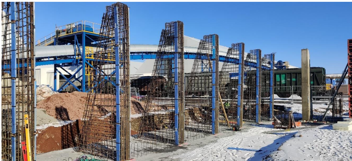
Kuva 7. Anturan päälle nostettuja siipimuurien raudoituksia
