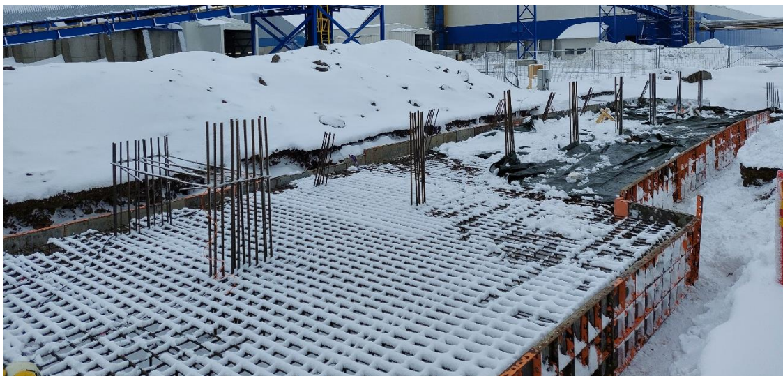
Kuva 6. Raudoitettu anturamuotti
