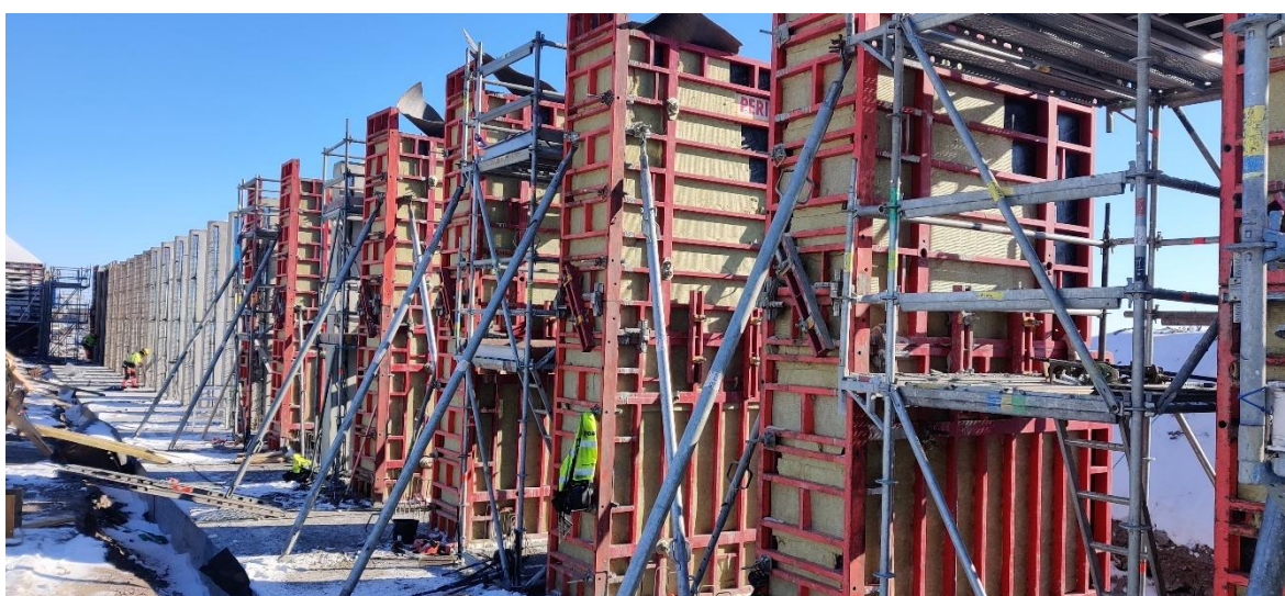
Kuva 8. Paikalleen asennettuja ja eristettyjä siipimuurien muotteja
