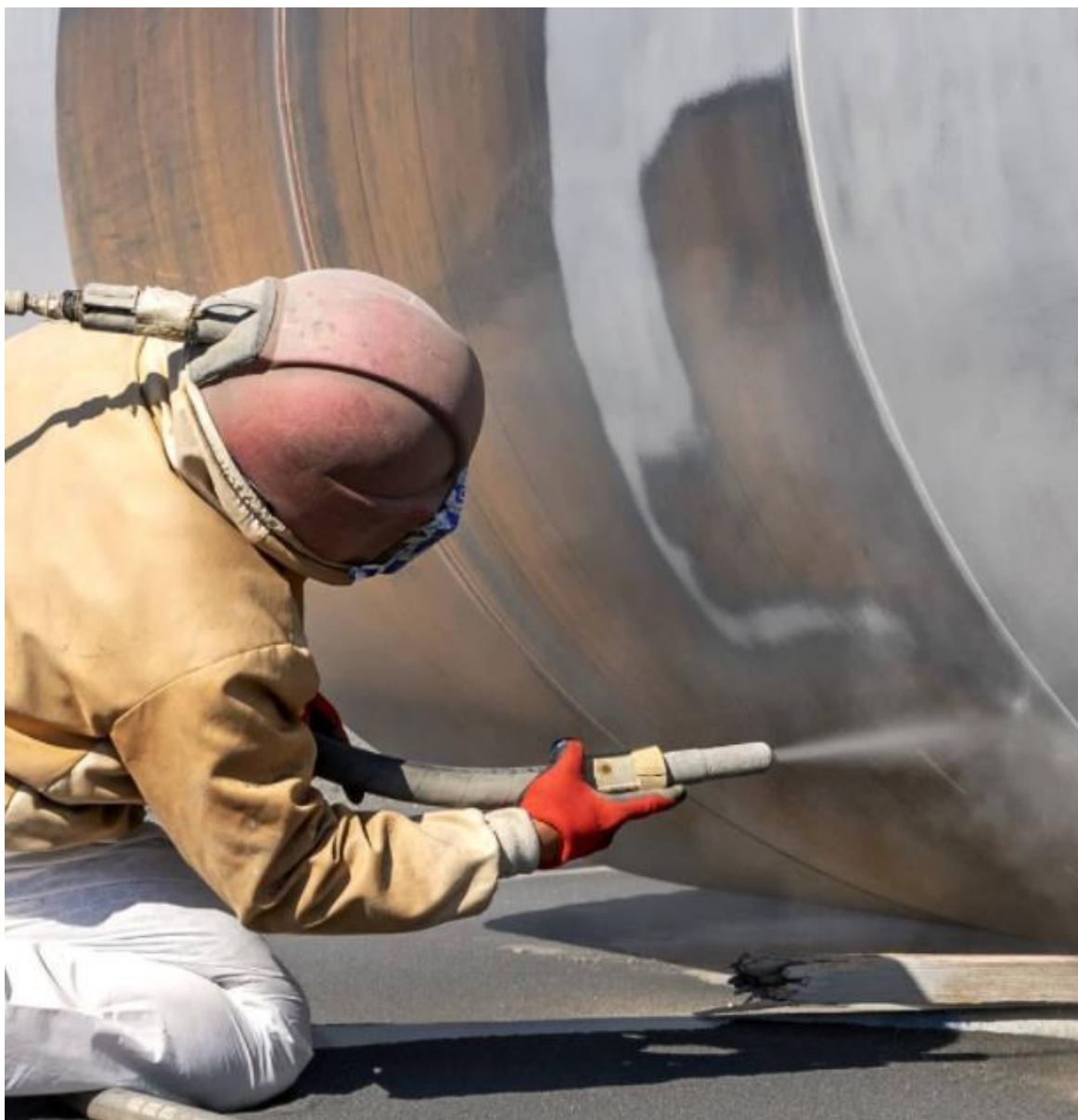
KUVA 2. Teräsosan suihkupuhdistus avopuhalluksena (Steel-Bull julkaisuajankohta tuntematon)
