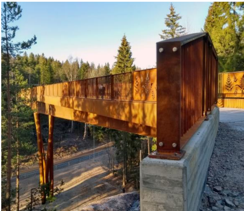
KUVA 1. Säänkestävästä teräksestä valmistettu silta (SSAB Weathring julkaisuaika tuntematon)
