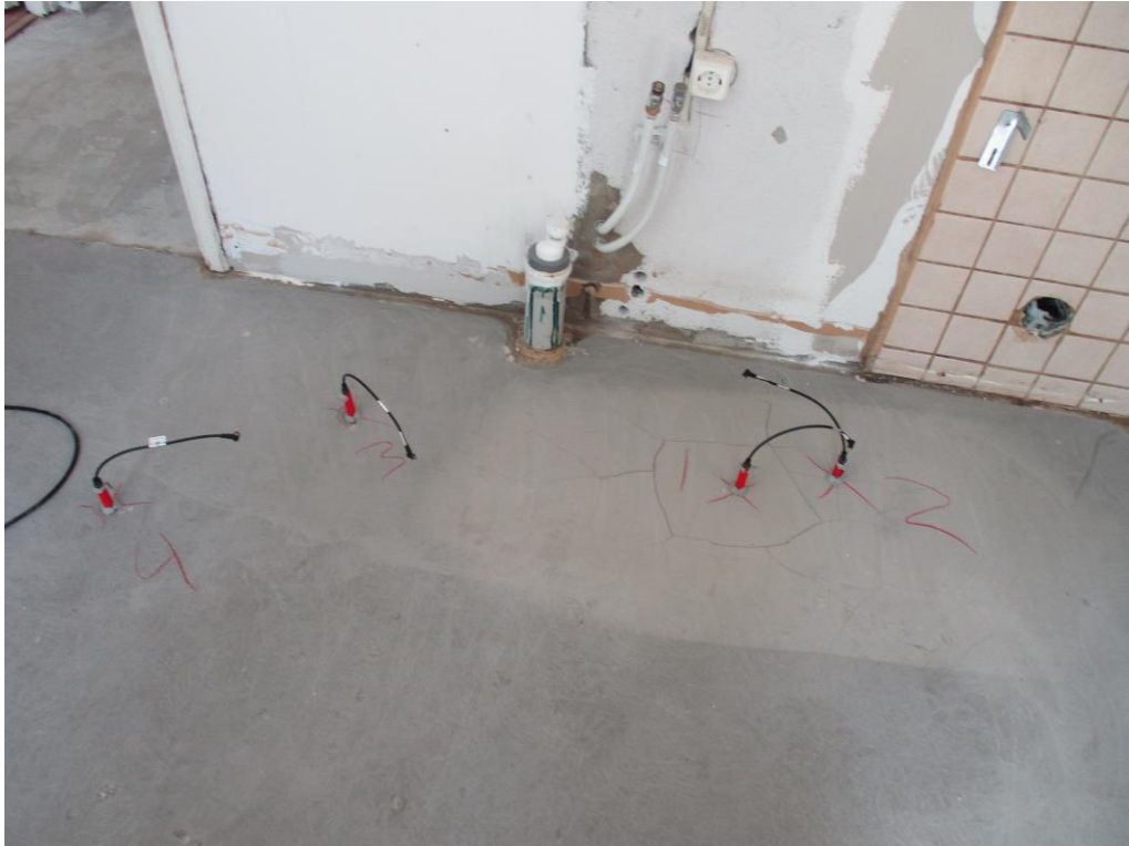
Kuva 4. Mittareikien porauksessa tulee huomioida rakenteissa kulkevat talotekniikan vedot. Mittaputken tiivistys tehdään "sinitarralla".
